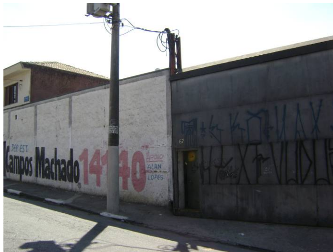
Foto 9.3.9.2 – 11: Executiva Estrutura Metálica. Rua Embiara, 67.
