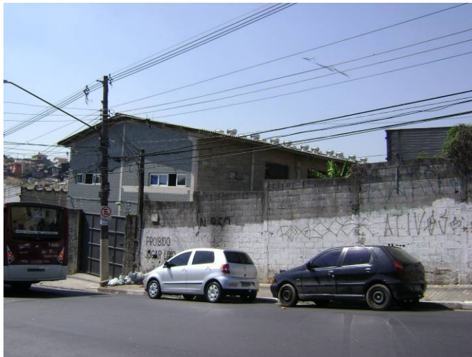
Foto 9.3.9.2-9: TMG Painéis elétricos. Rua Alba, 961
