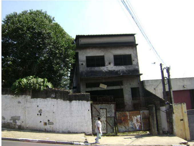
Foto 9.3.9.2-8: Terreno abandonado. Rua Alba,
