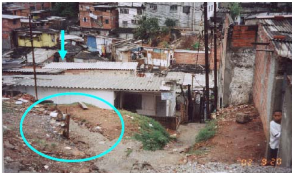
Foto 9.3.1-3: Ocupação na encosta e margem do córrego.
