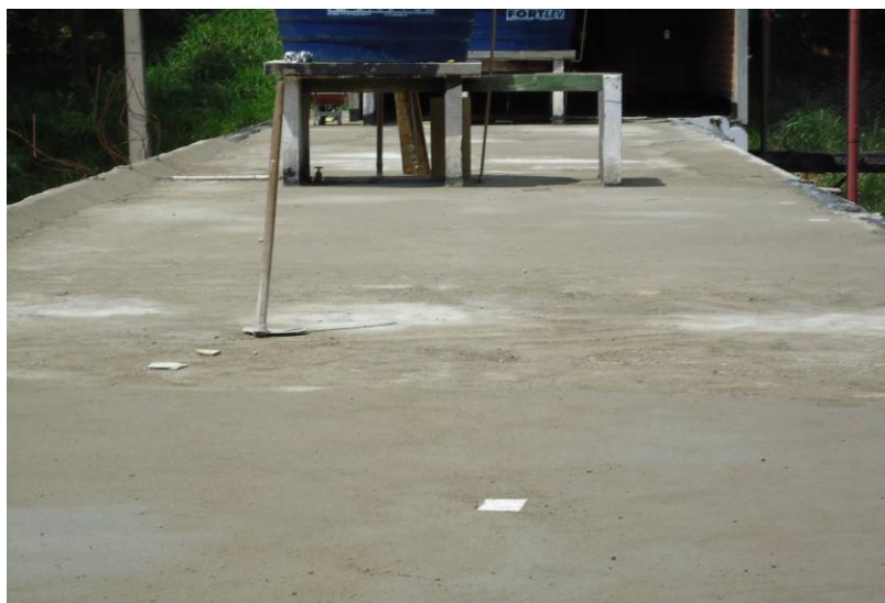
CONTRA PISO DA LAJE IMPERMEABILIZADA
