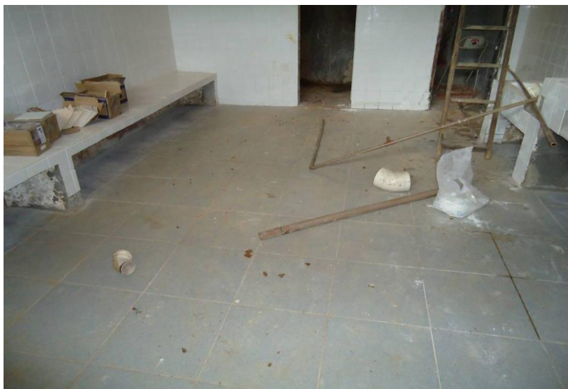
REFORMA DE VESTIÁRIOS ( PISO )
