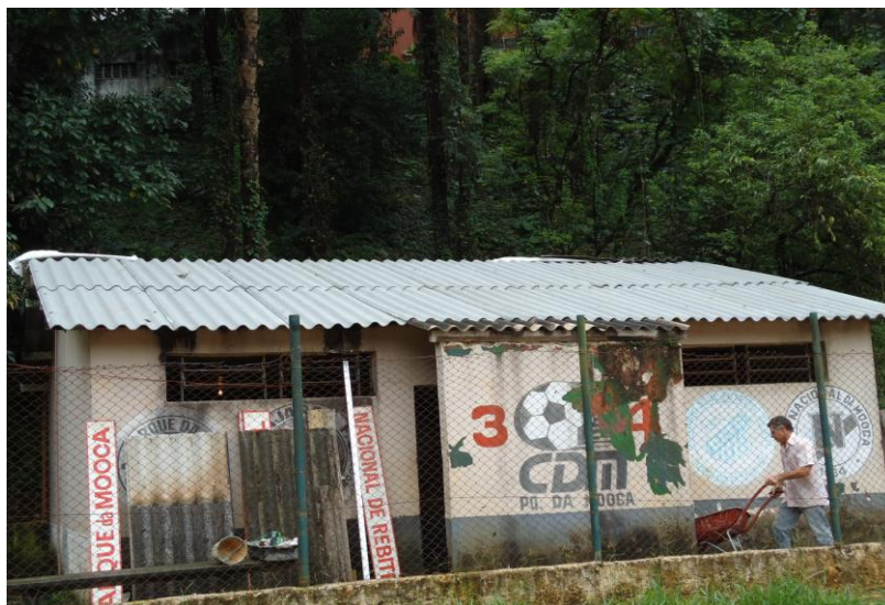
REFORMA DE VESTIÁRIOS ( TELHADO)
