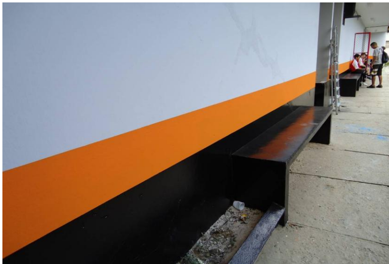
PINTURA FACHADA FRONTAL
