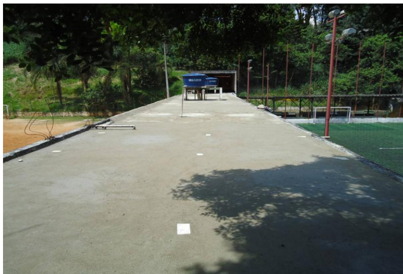
CONTRA PISO DA LAJE IMPERMEABILIZADA
