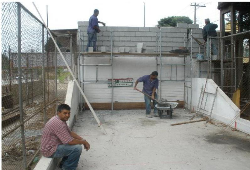
**OBRAS QUADRA DE BOCHA EXECUÇÃO ALVENARIA**
