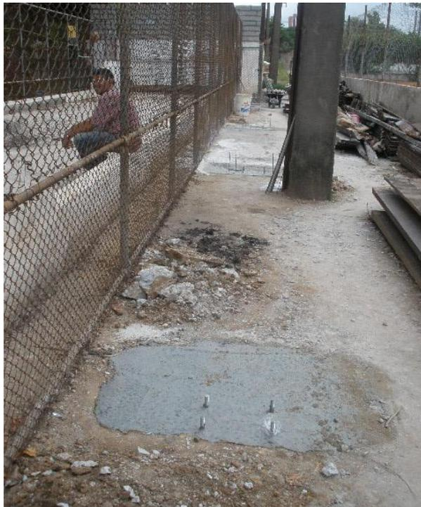
**OBRAS COBERTURA QUADRA DE BOCHA CONCRETAGEM BASE DOS PILARES**
