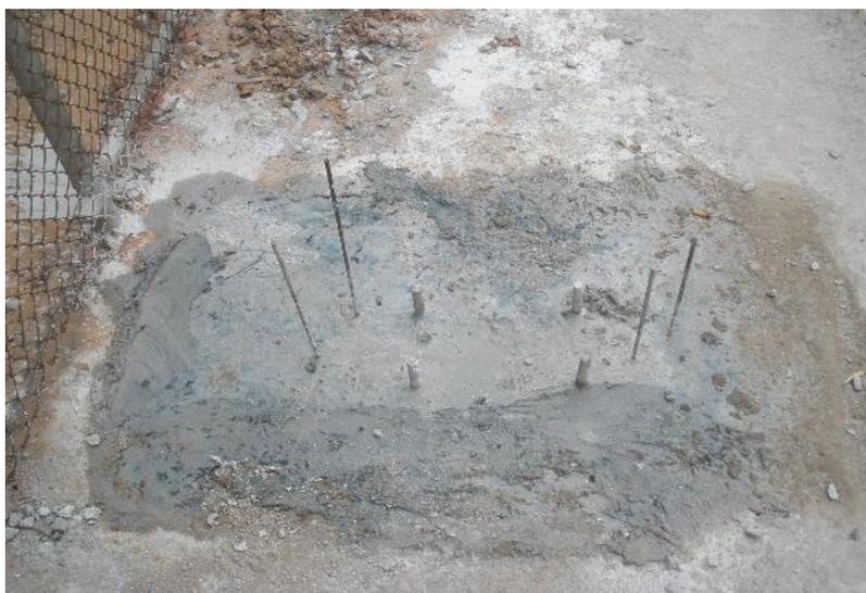
**OBRAS COBERTURA QUADRA DE BOCHA CONCRETAGEM BASE DOS PILARES**
