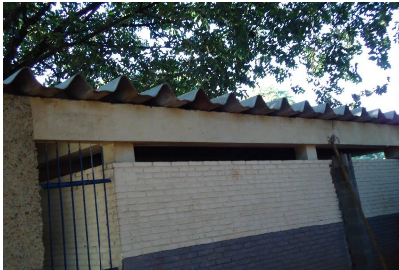
TELHADO REFORMADO BANHEIRO PÚBLICO
