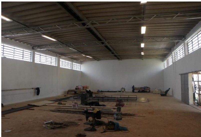
TELHADO DO GINÁSIO RECUPERADO E PINTURA INICIADA
