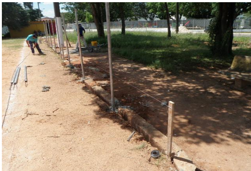
REMOÇÃO DE ALAMBRADO DANIFICADO PARA SUBSTITUIÇÃO
