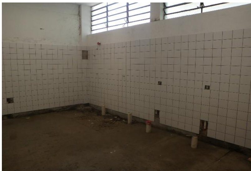
REFORMA DO VESTIÁRIO
