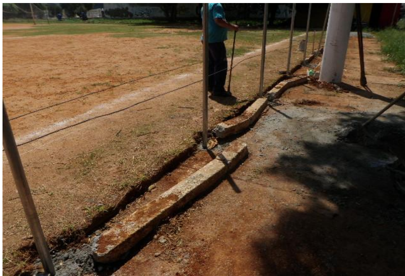
REMOÇÃO DE ALAMBRADO DANIFICADO PARA SUBSTITUIÇÃO
