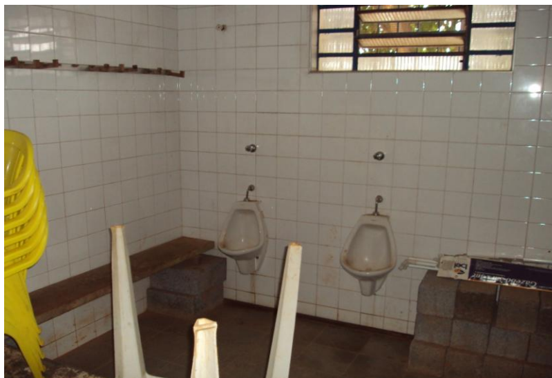
REFORMA DOS VESTIARIOS
