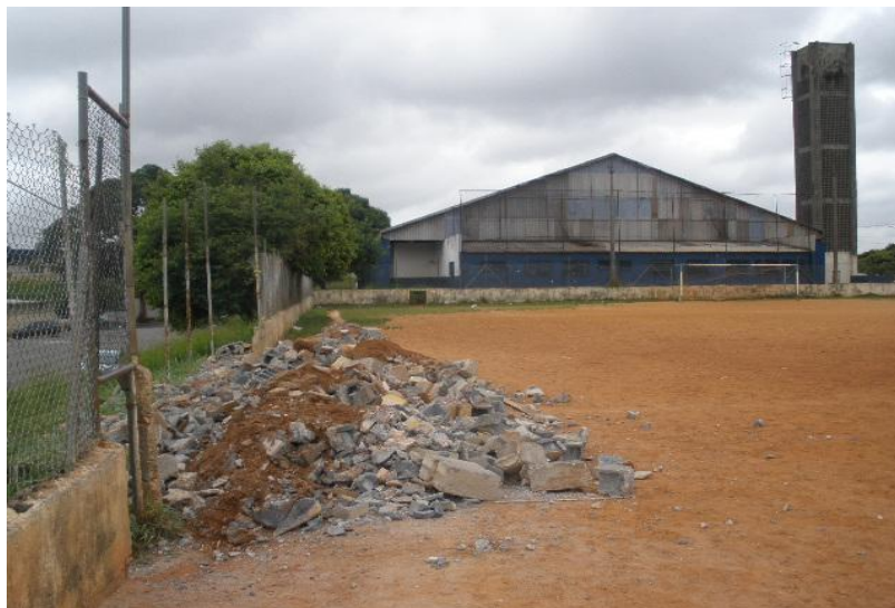
DEMOLIÇÃO BANCOS DE RESERVA DETERIORADOS
