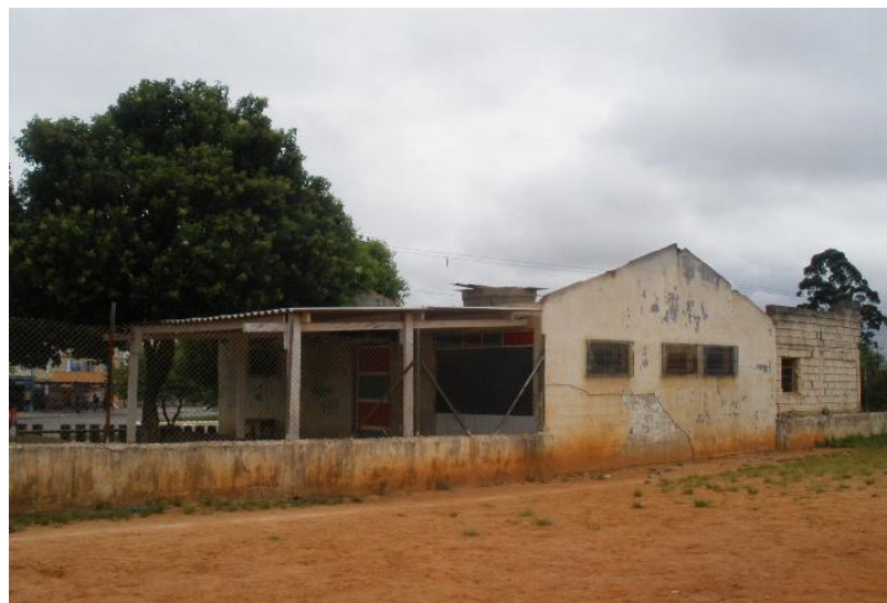
RETIRADA DE TELHADO E MADEIRAMENTO
