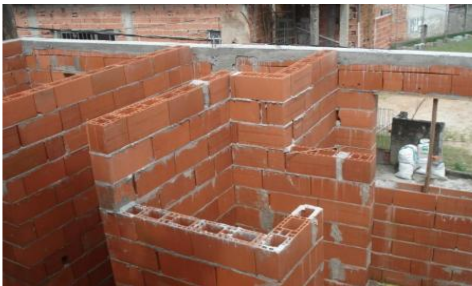
VISTA INTERNA DA OBRA
