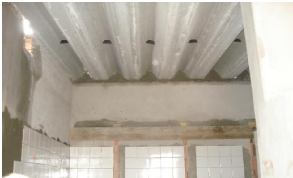
EXECUÇÃO DE REVESTIMENTO INTERNO
