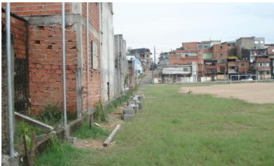
EXECUÇÃO DO ALAMBRADO
