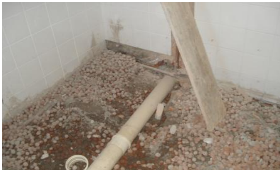
ENCHIMENTO DO PISO COM ARGILA EXPANDIDA
