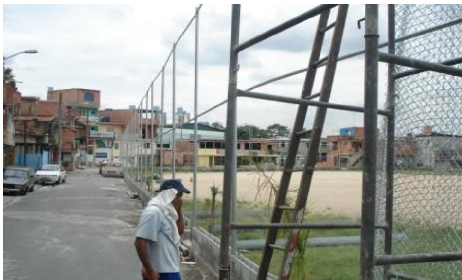
EXECUÇÃO DE ALAMBRADO
