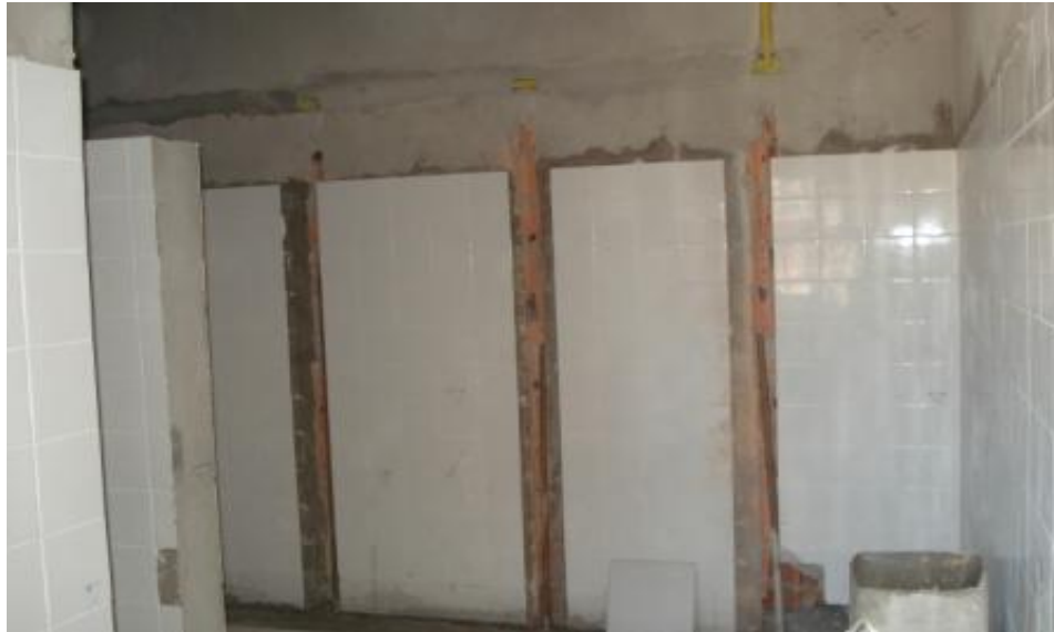
EXECUÇÃO DE REVESTIMENTO INTERNO E REDE HIDRÁULICA
