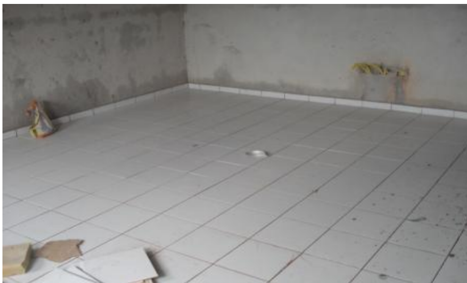
EXECUÇÃO DE REVESTIMENTO INTERNO
