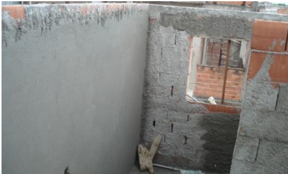
REVESTIMENTO INTERNO
