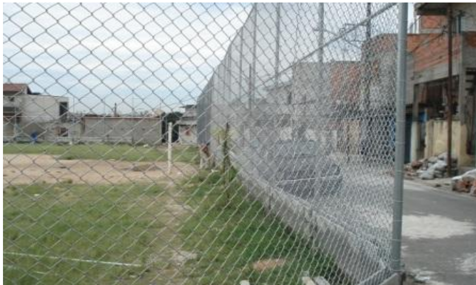
EXECUÇÃO DE ALAMBRADO
