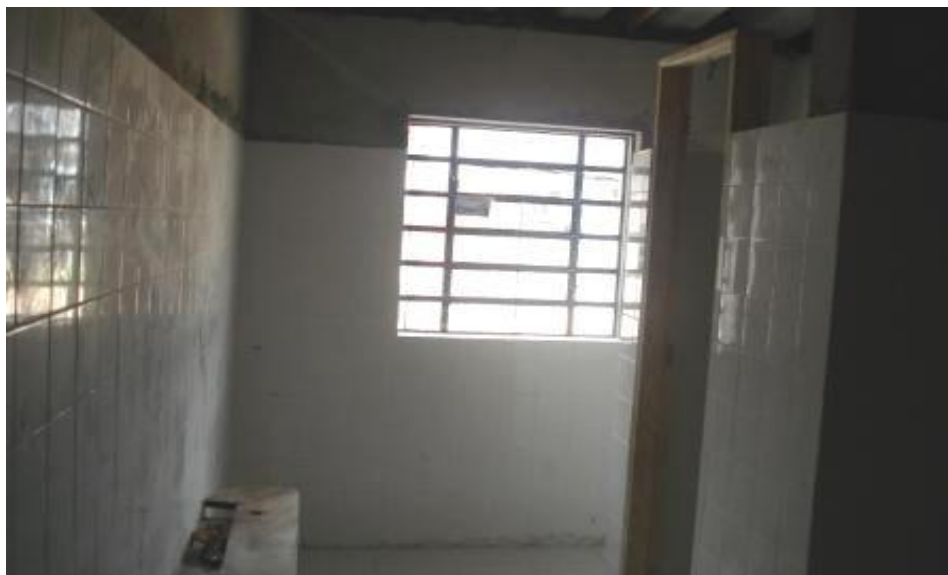
EXECUÇÃO DE REVESTIMENTO INTERNO
