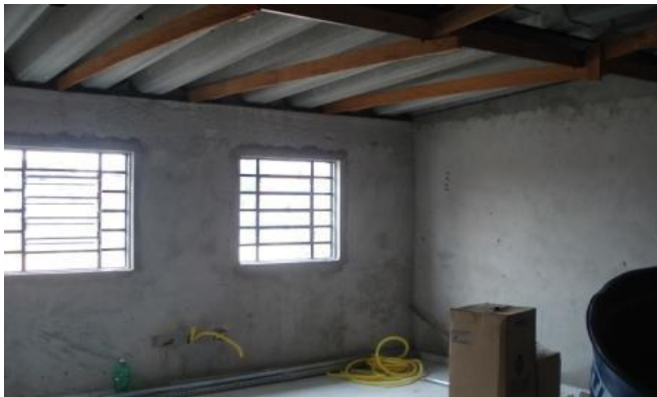
EXECUÇÃO ENTARUGAMENTO PARA INSTALAÇÃO DE FORRO DE GESSO
