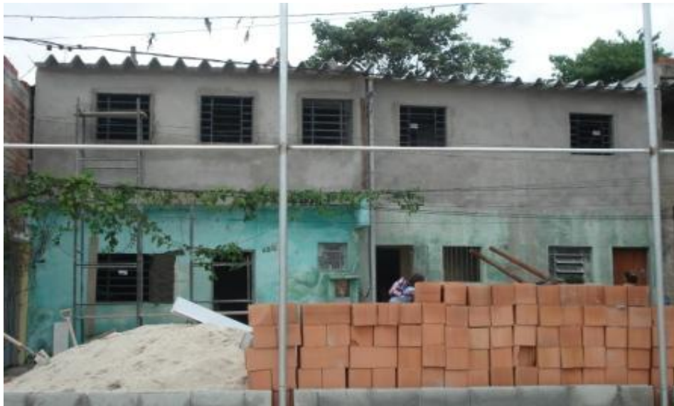
VISTA FRONTAL (COBERTURA CONCLUÍDA)
