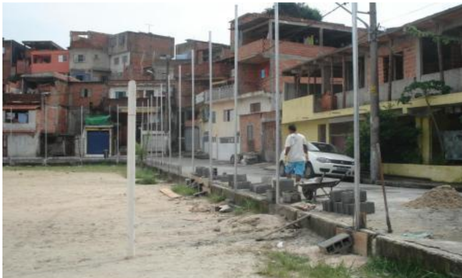
EXECUÇÃO DO ALAMBRADO
