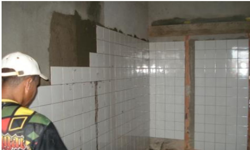
EXECUÇÃO DE REVESTIMENTO INTERNO
