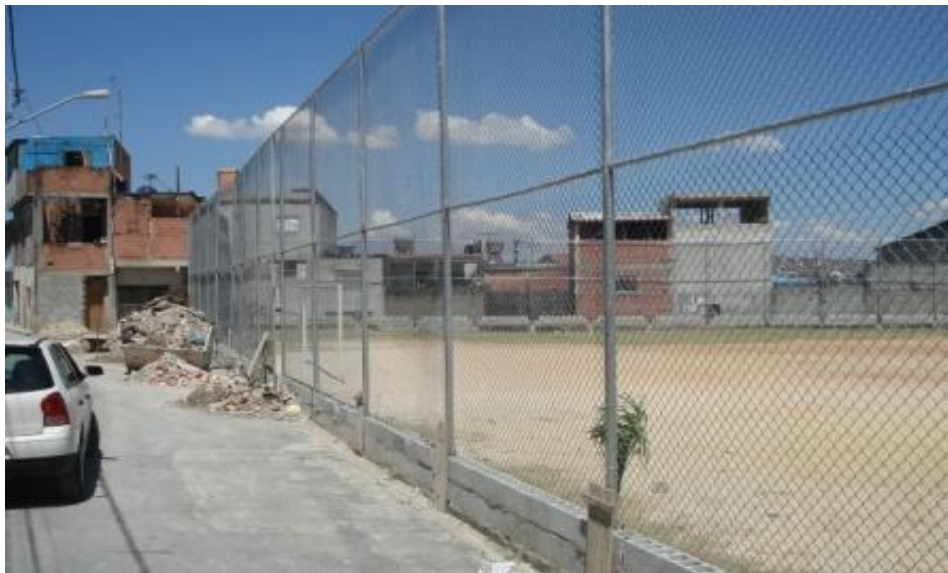
EXECUÇÃO DE ALAMBRADO - FASE FINAL
