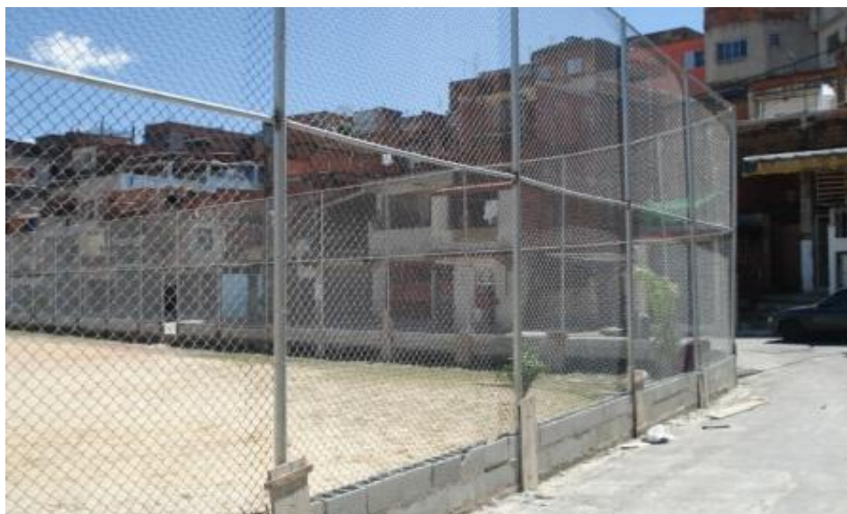
EXECUÇÃO DE ALAMBRADO - FASE FINAL
