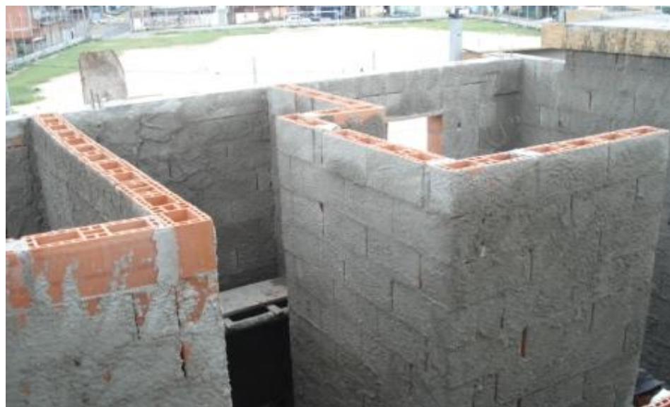
ALVENARIA CONCLUÍDA
