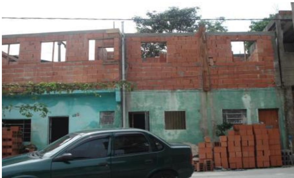
VISTA FRONTAL DA OBRA
