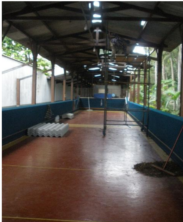
EXECUÇÃO REFORMA DO TELHADO
