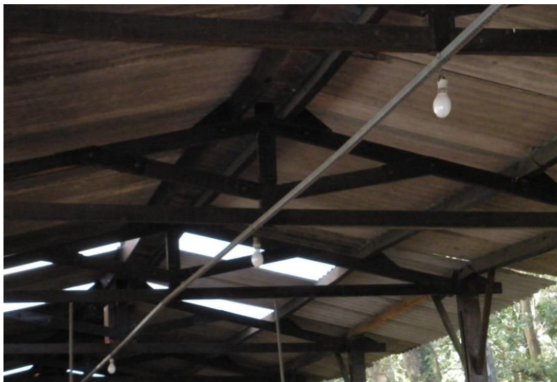
MANUTENÇÃO DO TELhado DA CANCHA DE BOCHA
