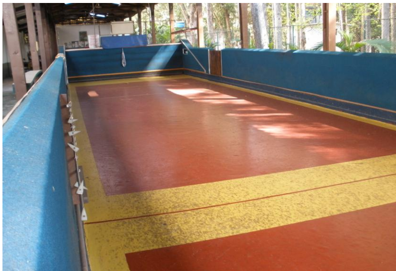
MANUTENÇÃO DO PISO DA CANCHA DE BOCHA
