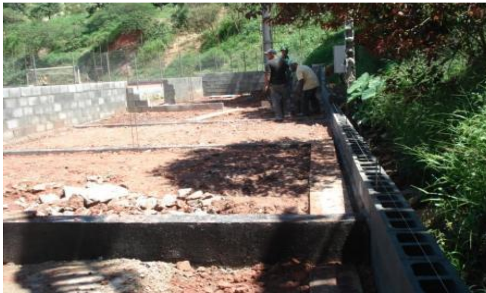
EXECUÇÃO DA ALVENARIA
