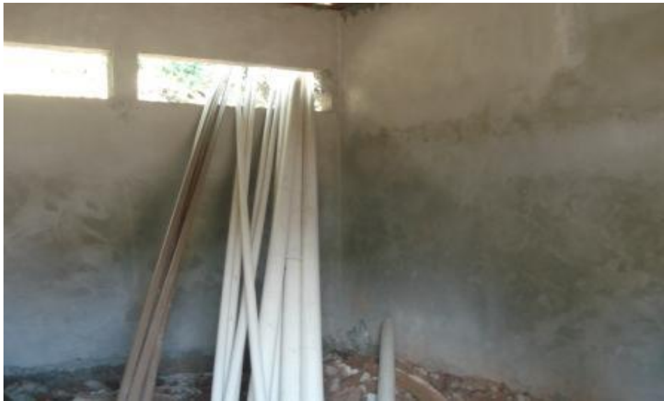
INICIO DA INSTALAÇÃO HIDRÁULICA
