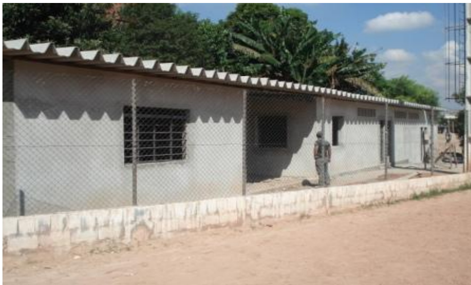
VISTA GERAL DO EQUIPAMENTO
