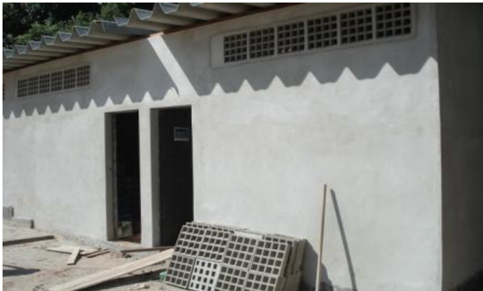
ENTRADA DOS VESTIÁRIOS
