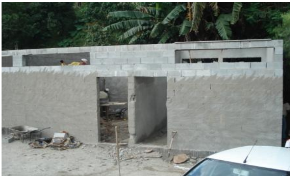
EXECUÇÃO REBOCO INTERNO
