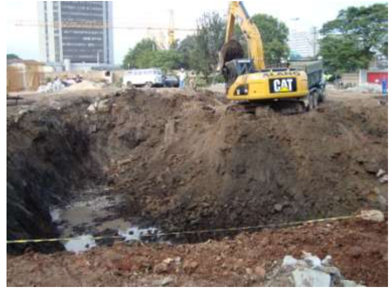
Terminal Capri – início de escavação
