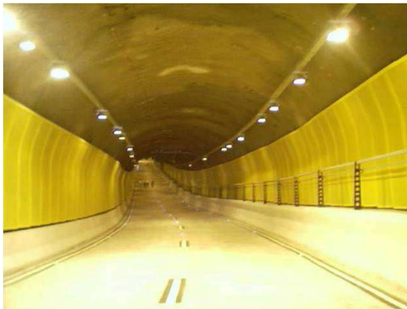
Passagem em desnível das Av. Faria Lima x Av. Cidade Jardim
