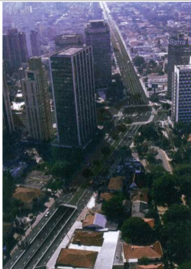
Passagem em desnível das Av. Faria Lima x Av. Rebouças x Av. Eusébio Matoso
