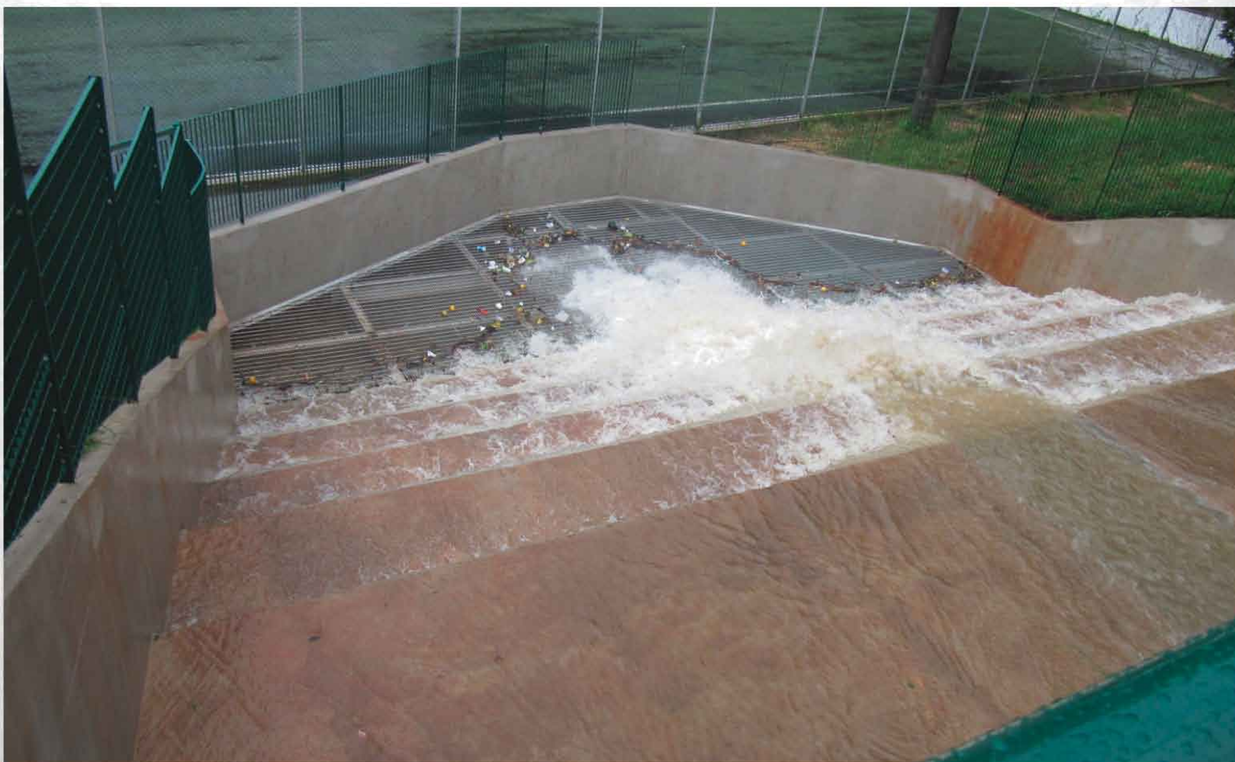
Vertedouro em pleno funcionamento
