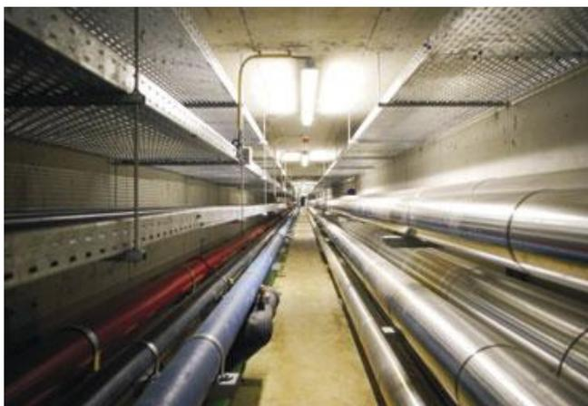
Esse sistema é utilizado, principalmente, na Europa, por meio do qual são construídas galerias (túneis) com compartilhamento total de gás, água, esgoto, águas pluviais, energia, telecomunicações, etc.
