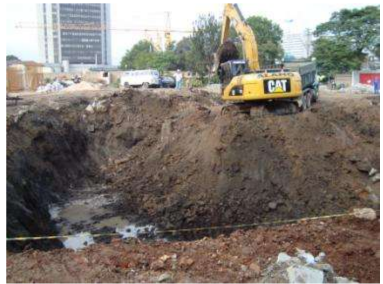
Terminal Capri – início de escavação
