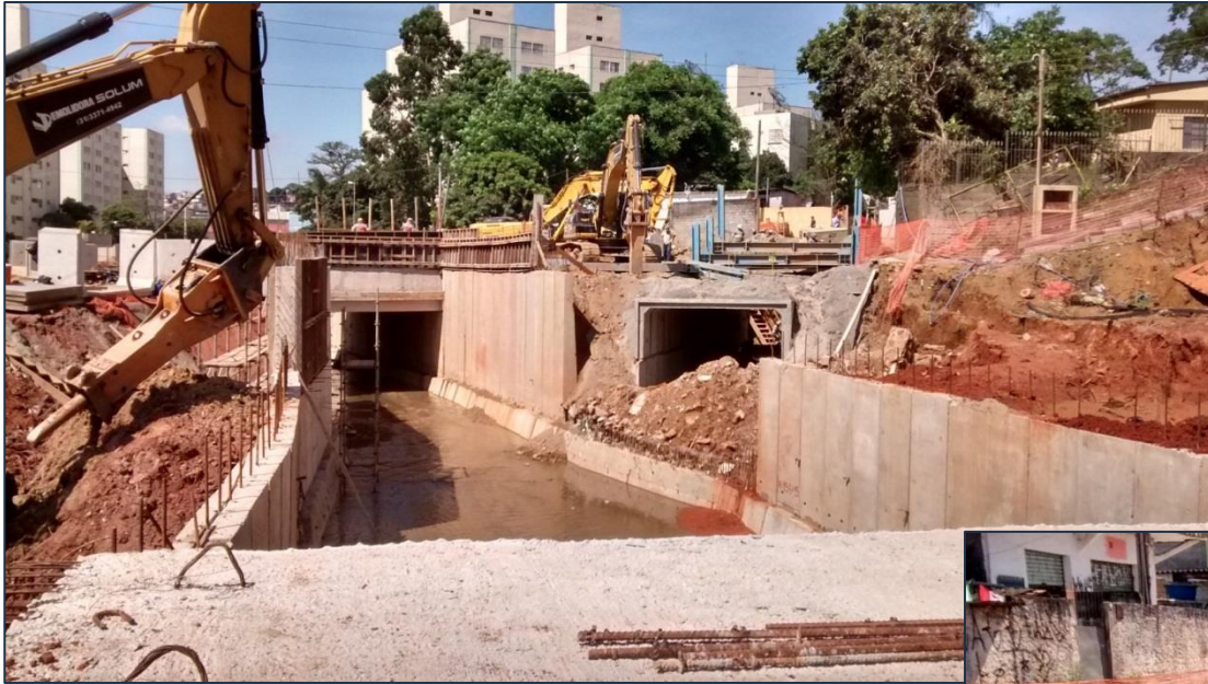
Execução de canal na Rua Capitãneas Hereditárias x Jardim Letícia
