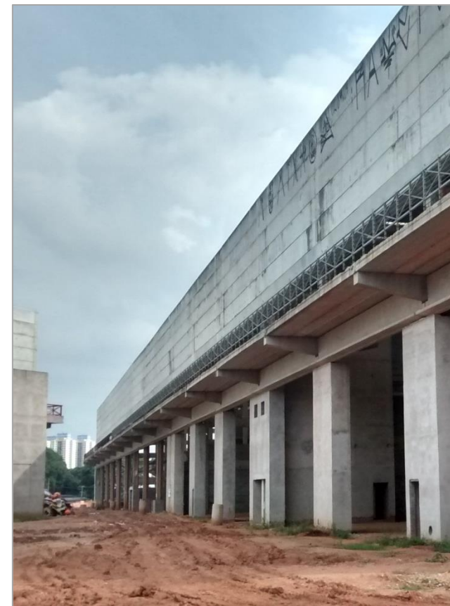
Bloco C - Em obras
