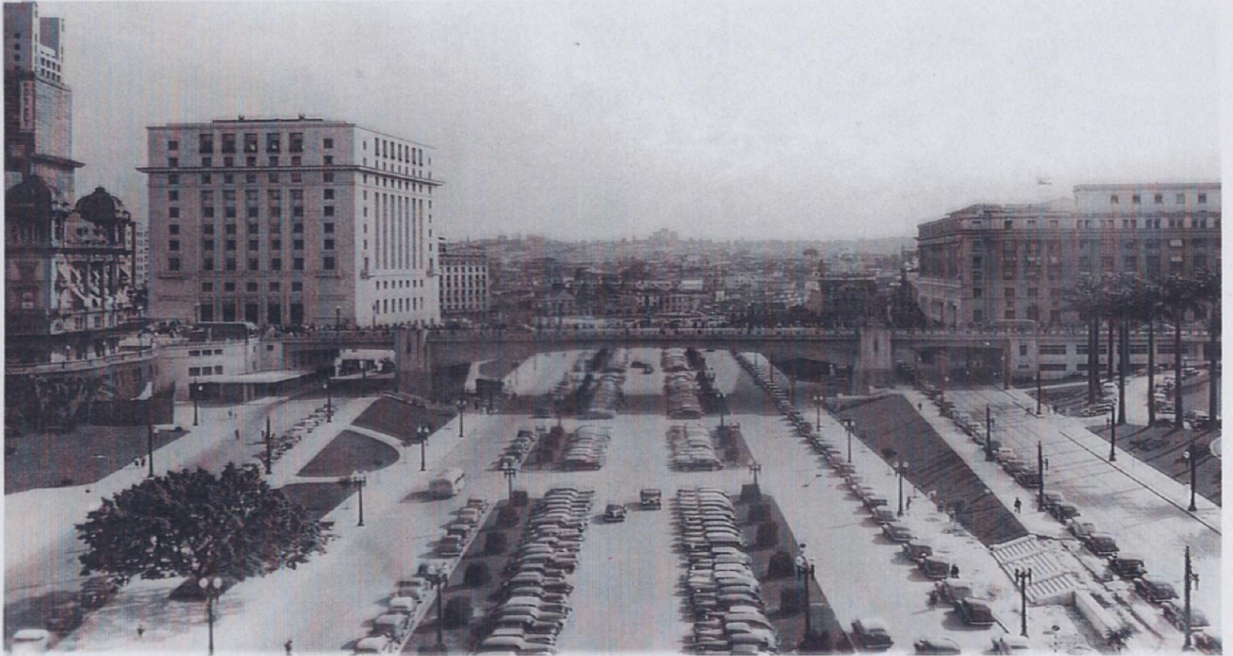
O novo Viaduto do Chá e a
