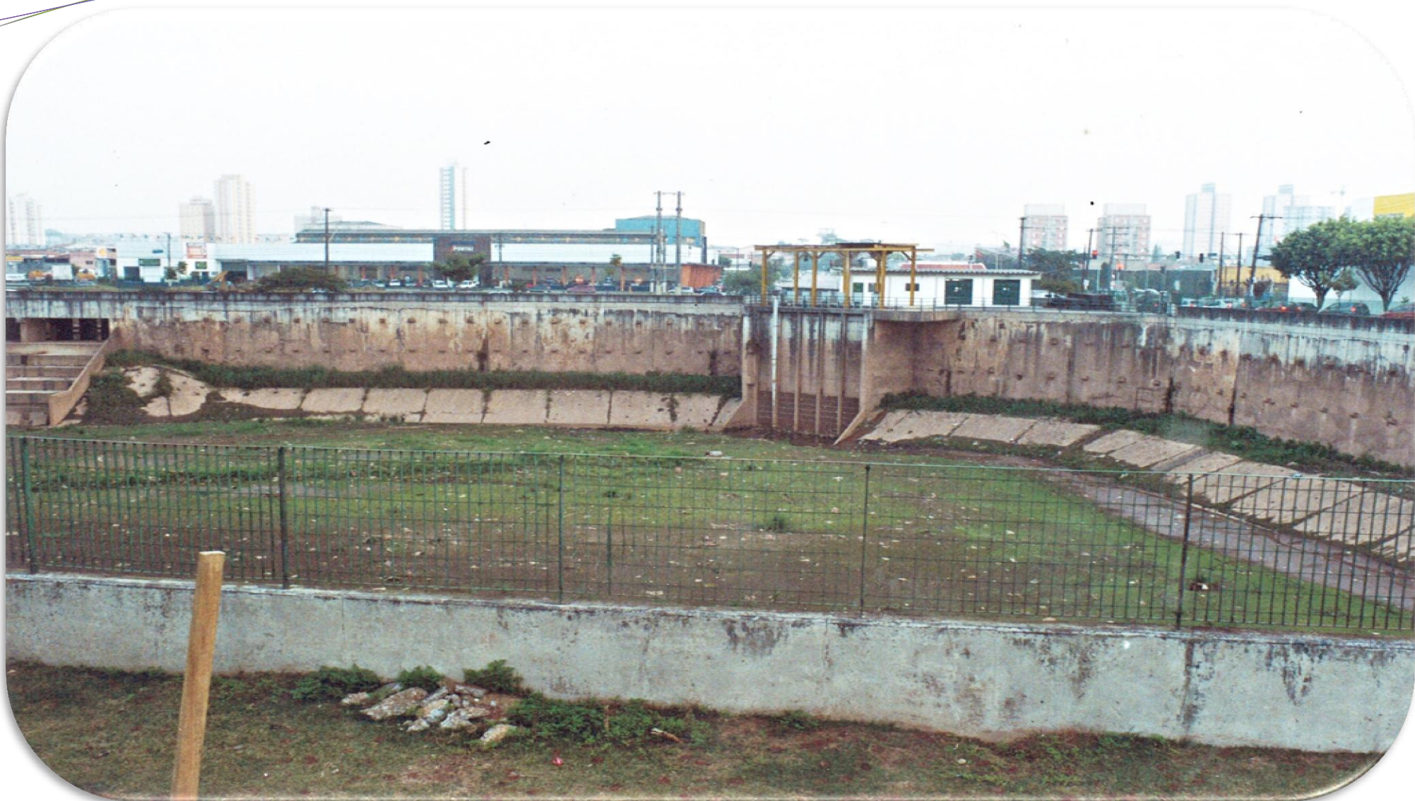
Reservatório do Pirajussara
