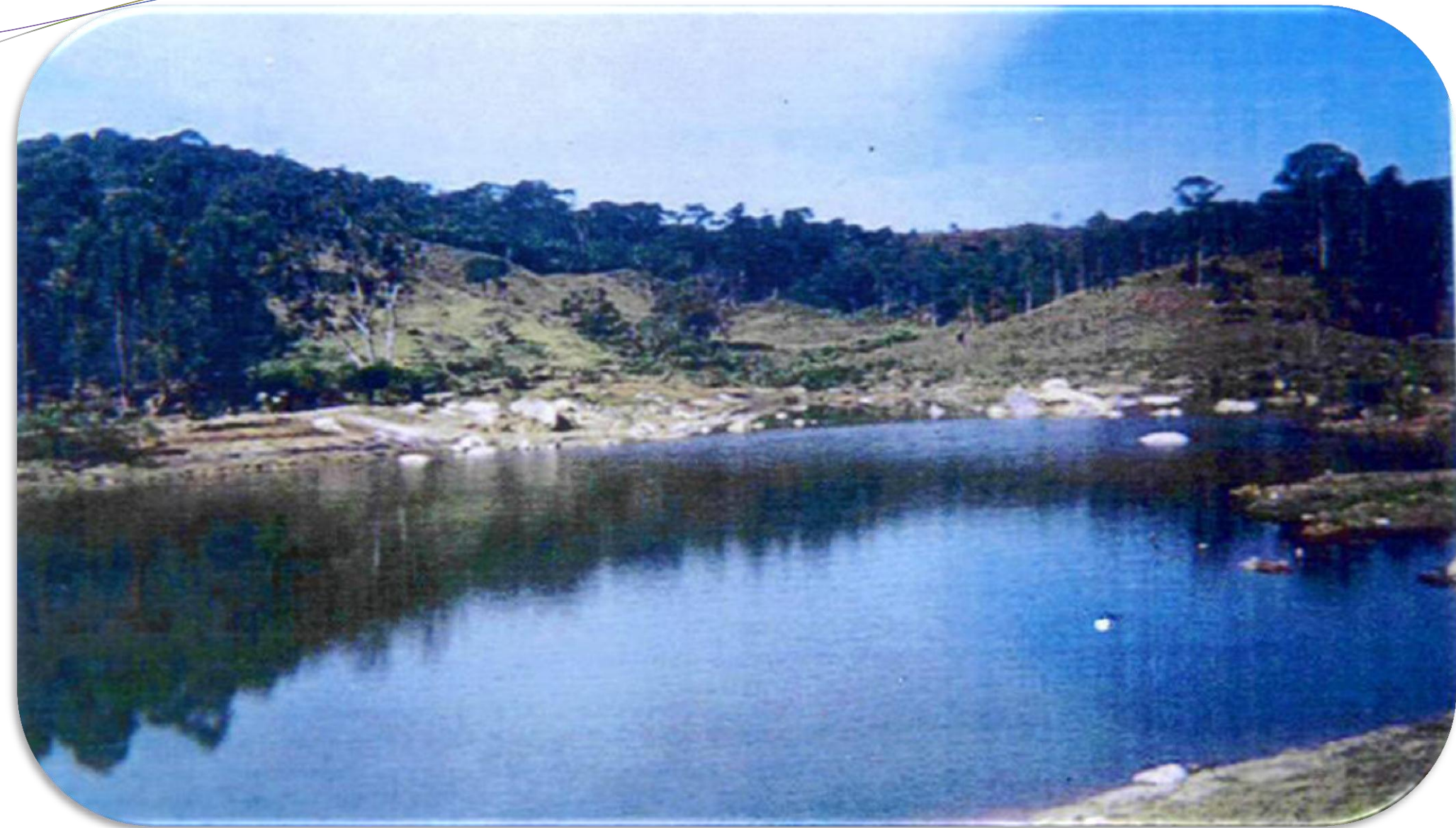
Reservatório do córrego Bananal
