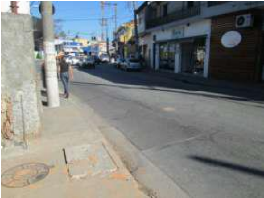
rua antes da intervenção
