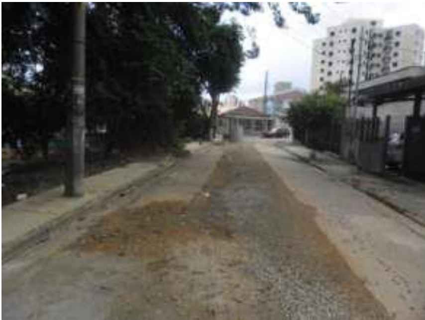
obra em andamento reconstituição da pavimentação
