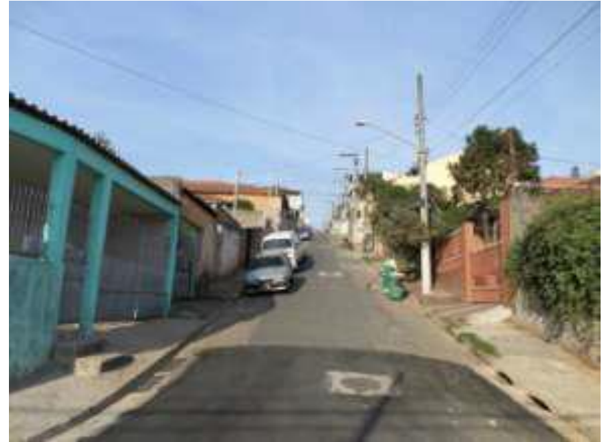
obra concluída vista da área após conclusão da obra
