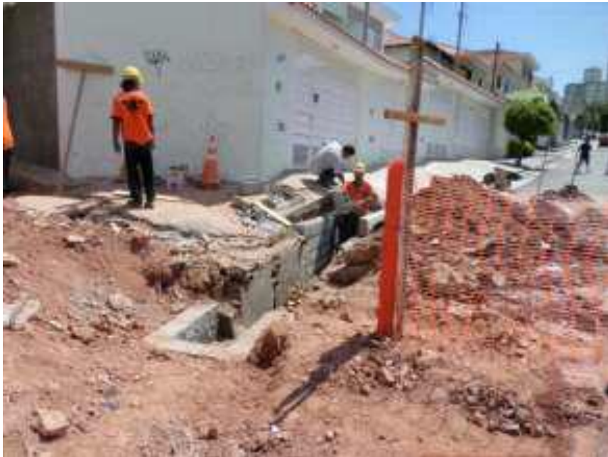
obra em andamento
