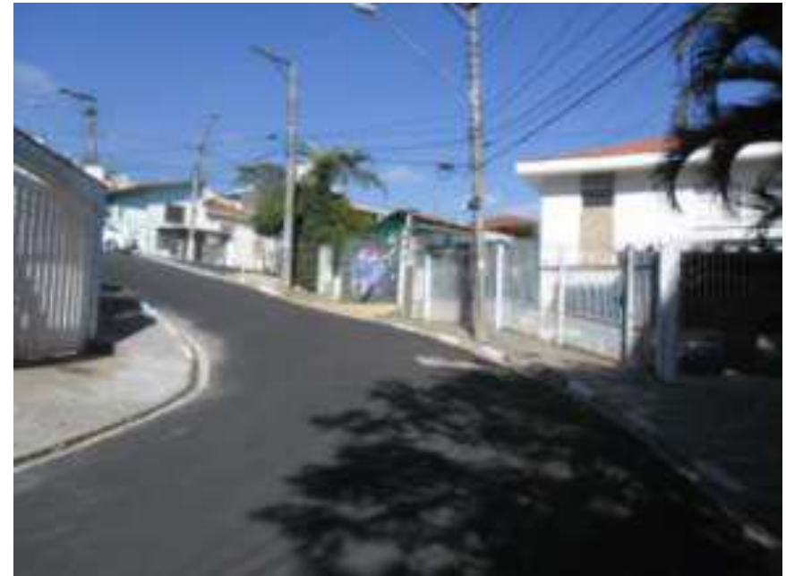
obra concluída vista da área após a intervenção
