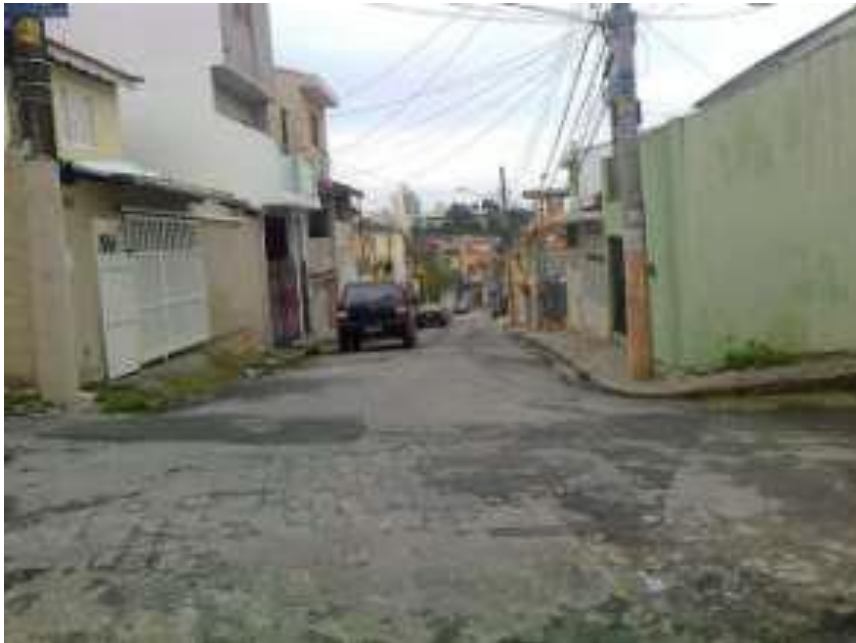
rua antes da intervenção
