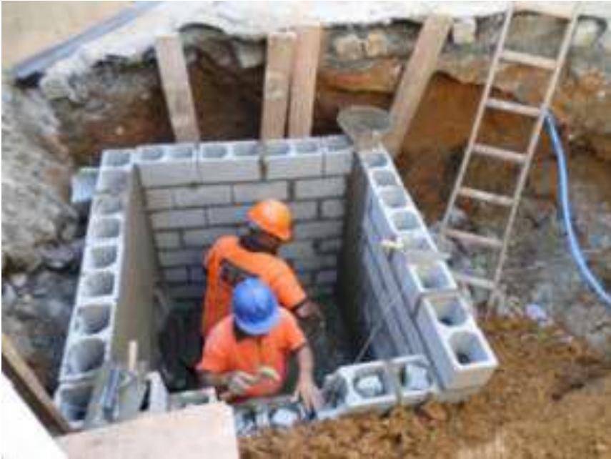
obra em execução execução da drenagem entre poços de visita
