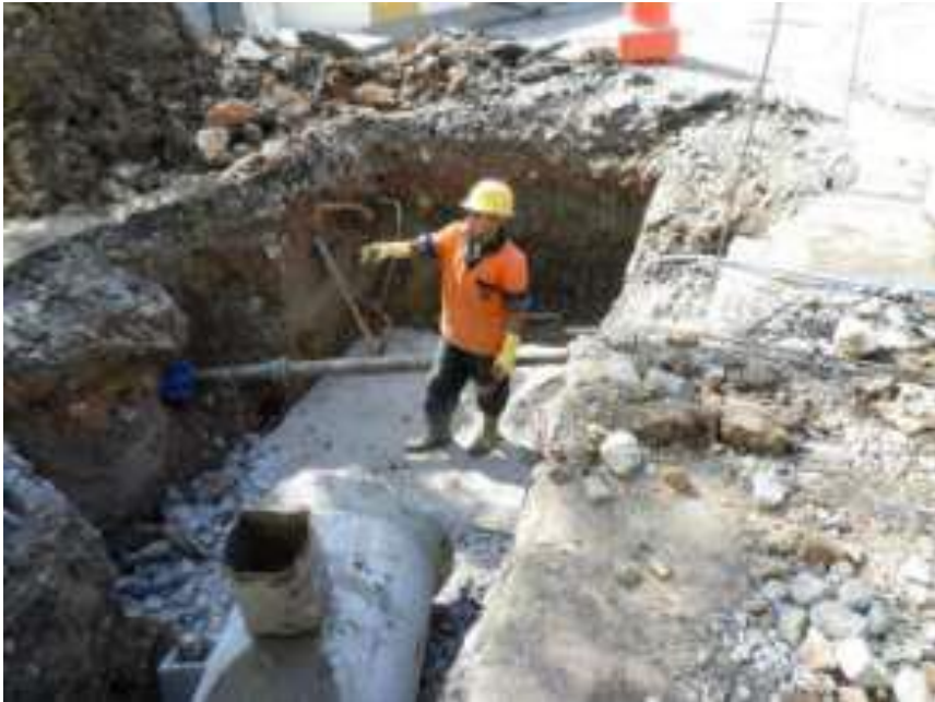
obra em execução Implantação de rede de drenagem
