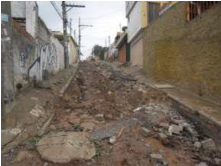
obra em andamento
