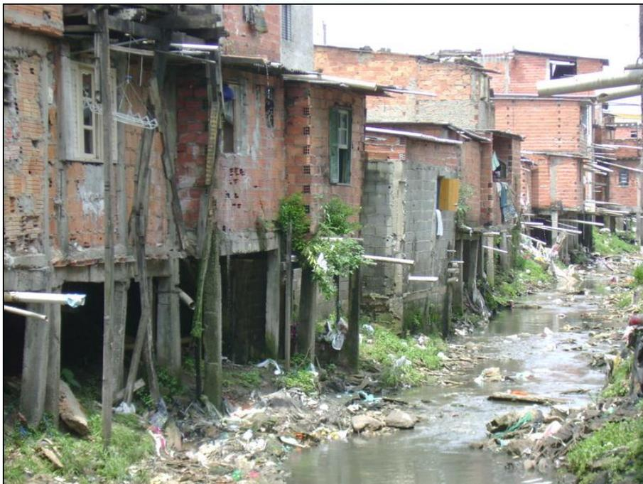
Foto FC-MG-01-04: Moradias construídas muito próximas ao leito do córrego. Observar o lixo, o entulho e as águas servidas lançadas diretamente na drenagem.
