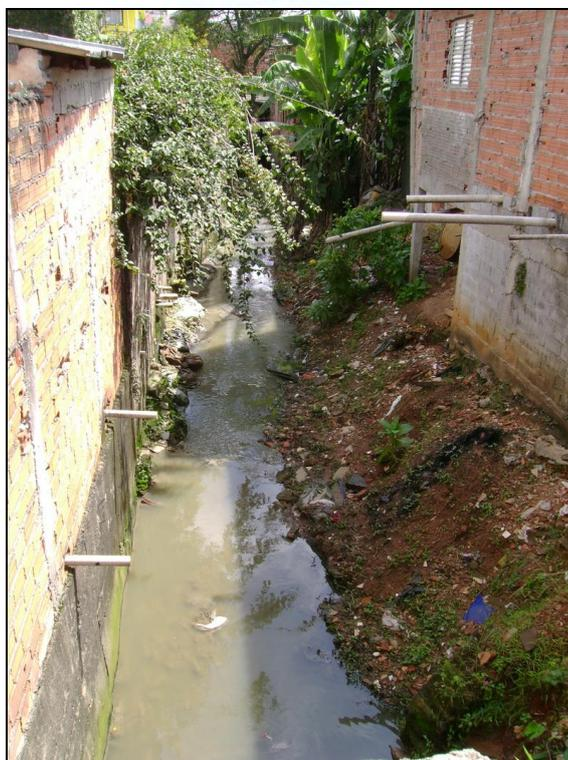
Foto FC-MG-02-02: Trecho de drenagem, com taludes marginais sem evidências de solapamento, moradias em alvenaria e parcialmente canalizado pela parede da própria moradia.
