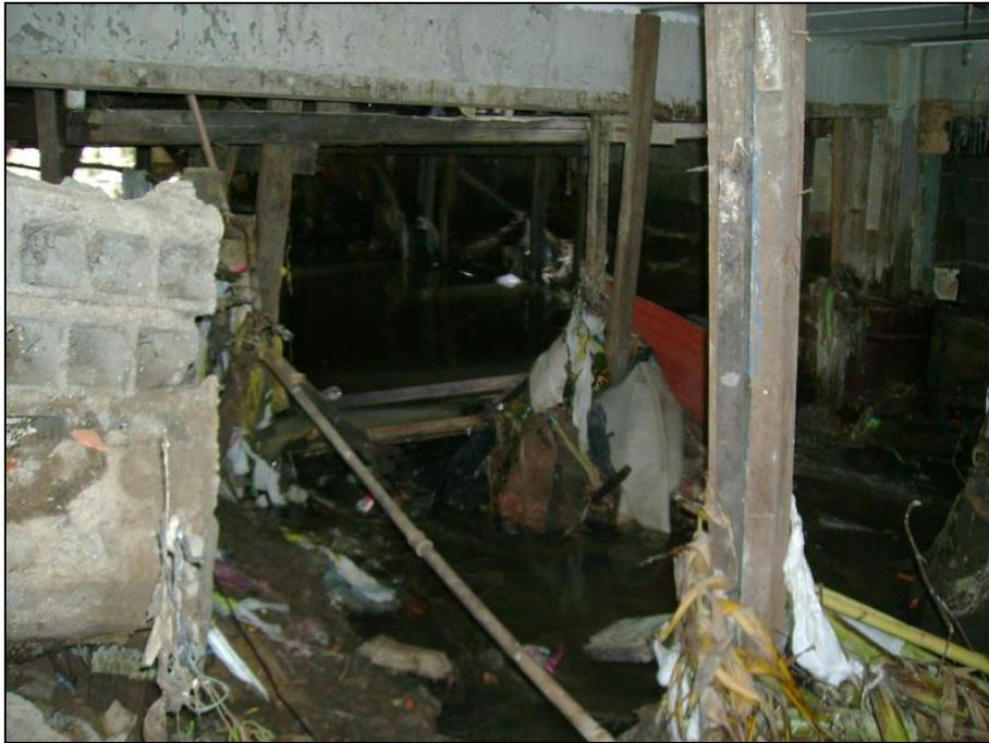
Foto FC-MG-02-11: Porção inferior das moradias. As casas são sustentadas por pilotis apoiados no interior da drenagem. Observar a grande quantidade de lixo e entulho acumulados.
