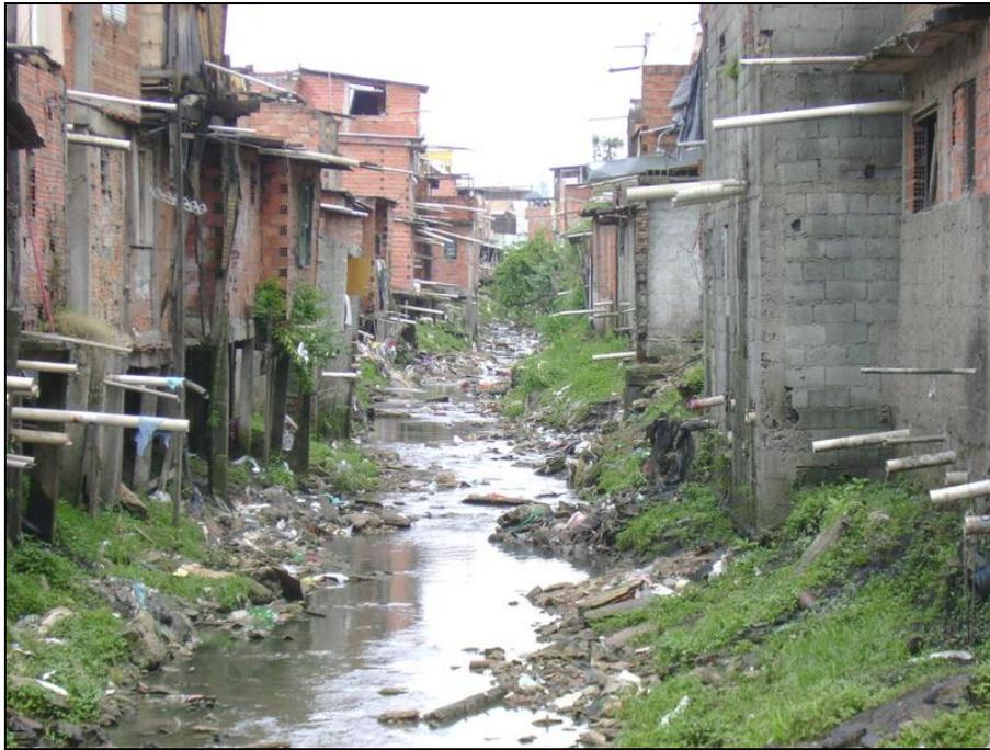
Foto FC-MG-01-03: Moradias construídas junto ao córrego. Observar o acúmulo de lixo e entulho na drenagem e o lançamento de águas servidas diretamente na água e taludes marginais.
