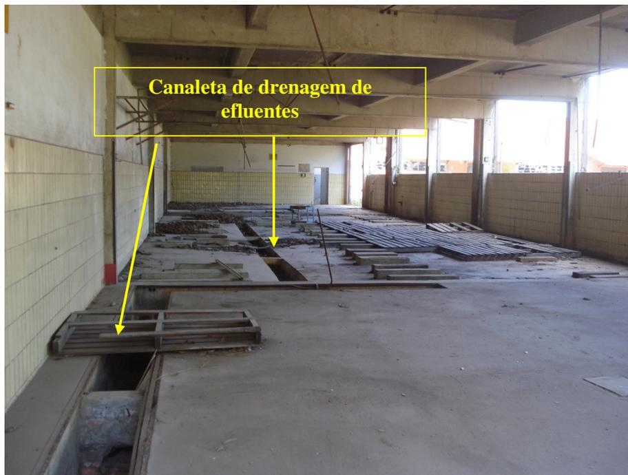
**Figura 5.2.3-20: Vista interna da área, com destaque para as canaletas de drenagem dos efluentes**
