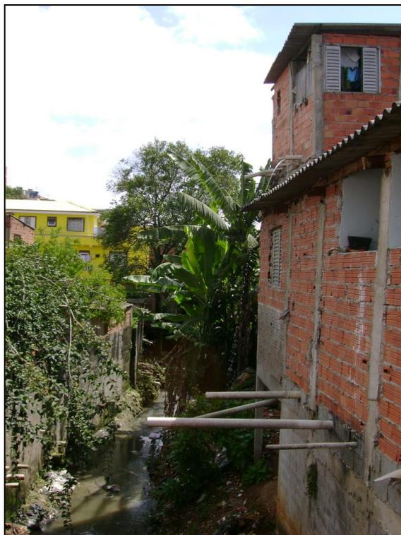
Foto FC-MG-02-03: Trecho do setor com ocupação em alvenaria e baixo risco a ocorrência de solapamento de margem.
