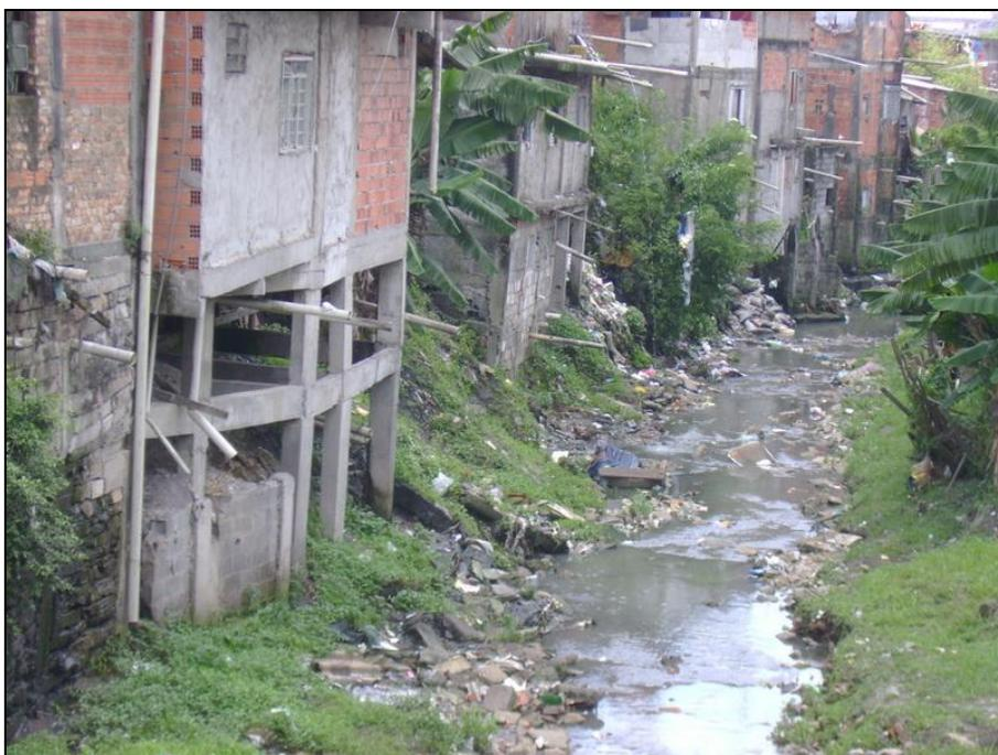
Foto FC-MG-01-05: Moradia construída sobre pilotis, muito próxima ao leito do córrego. Observar o lixo, o entulho e as águas servidas lançadas diretamente na drenagem.
