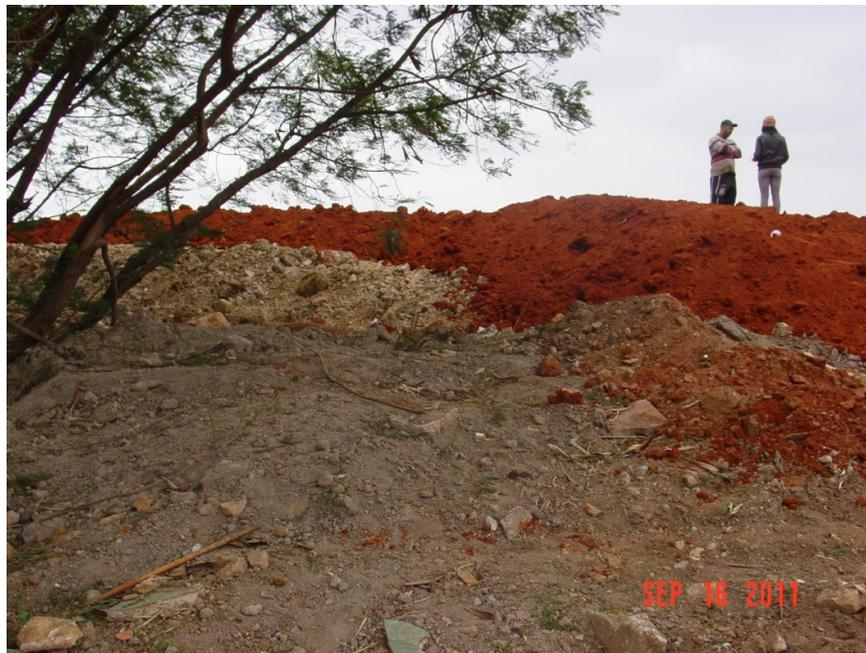
**Figura 5.2.3-5: Movimentos de terra existentes na área em estudo: notar os diferentes tipos de materiais utilizados, com destaque para a cobertura, com material argiloso.**
