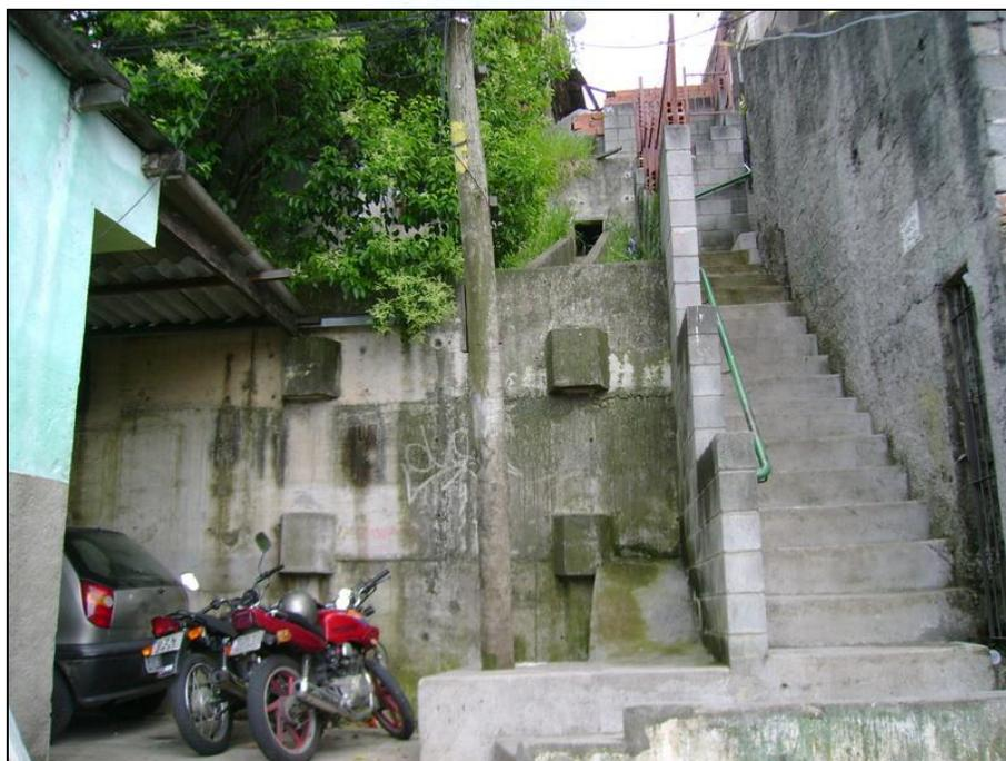
Foto FC-MG-02-06: Muro de arrimo construído para sustentação de parte da encosta do setor, associado à escadaria de acesso à área.
