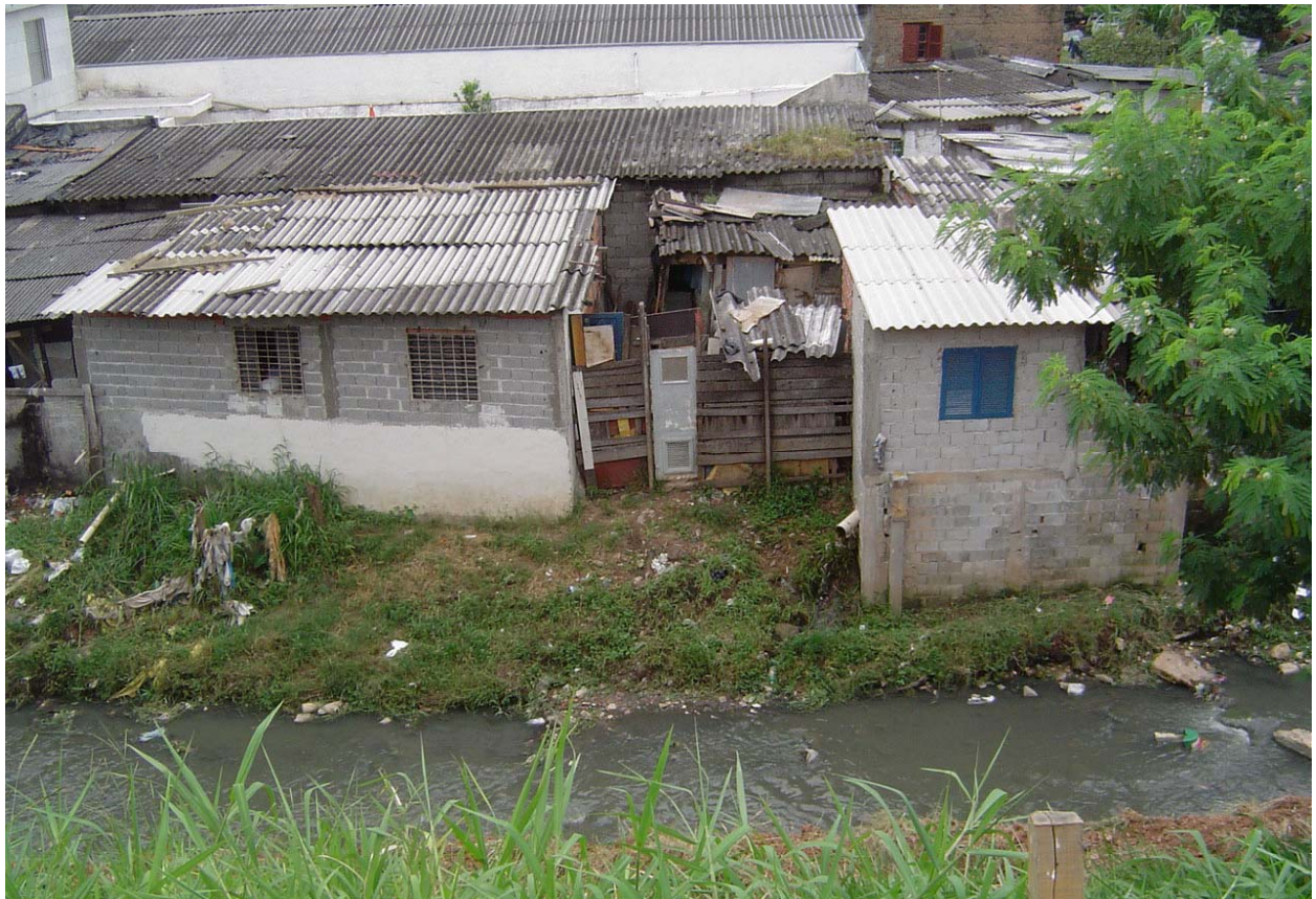
Foto 9.2.8.4-21: Outra tomada do mesmo local, mostrando a ocupação irregular junto ao córrego Água Espreada.
