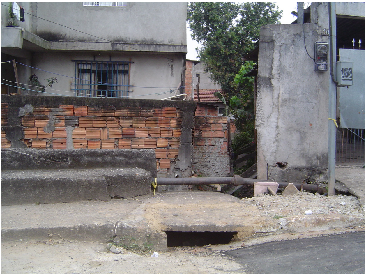
Foto 9.2.8.4-54: Drenagem que leva as águas pluviais da rua até o córrego Água Espriada. Ocupação consolidada ao longo do córrego.
