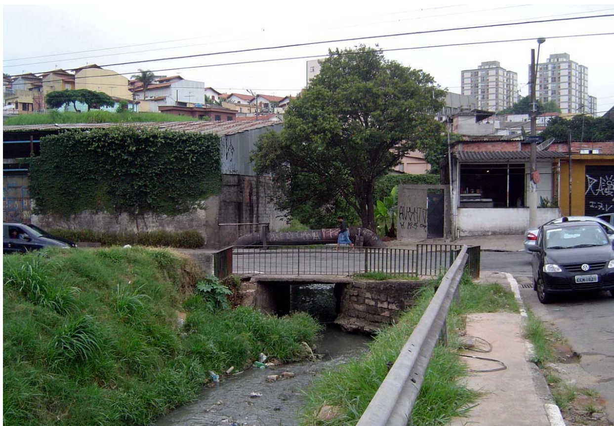
Foto 9.2.8.4-58: Canal do córrego Água Espreada, sentido de jusante (cruzamento das ruas Guassatungas e Rolinhas).
