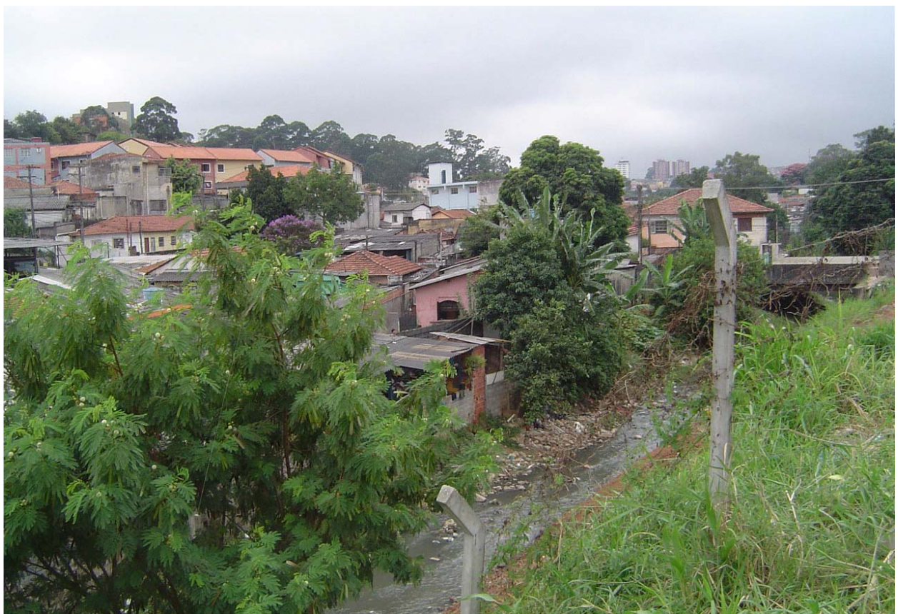
Foto 9.2.8.4-22: Outra tomada do mesmo local, mostrando a ocupação irregular junto ao córrego Água Espreada.
