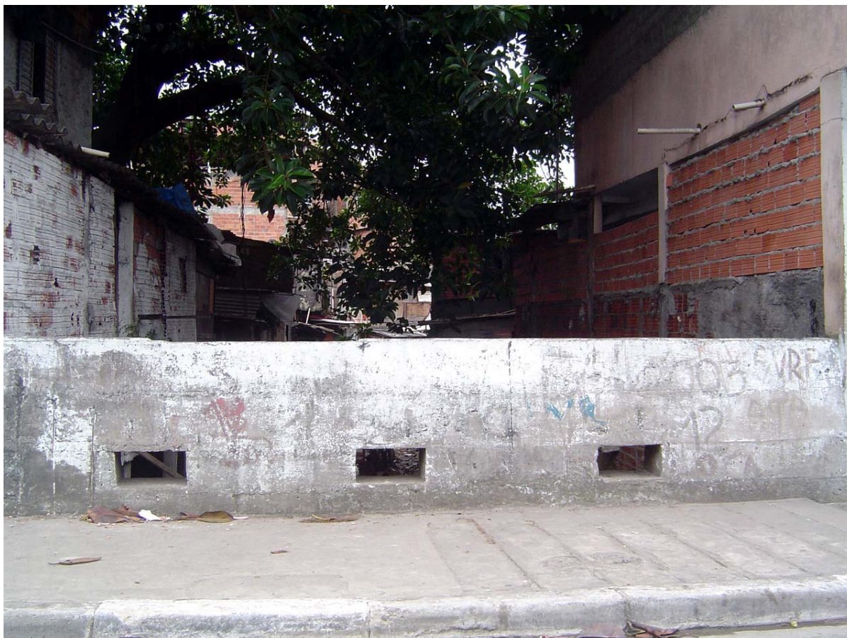
Foto 9.2.8.4-32: Travessia de córrego da Av. Rodrigues Montemor.
