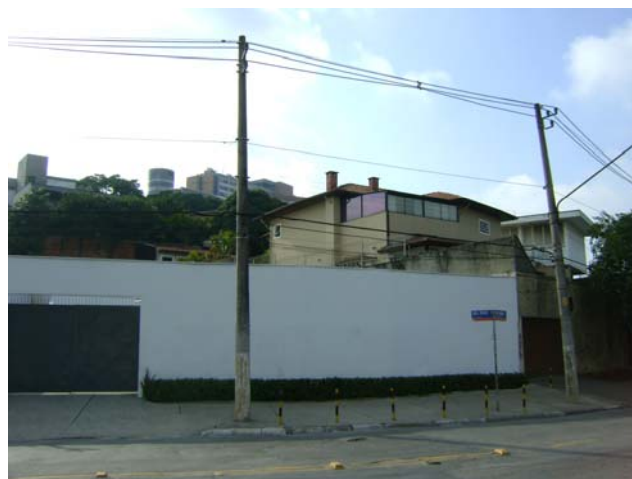
Foto 6.4.9.1-36: Bloco 02B – Residencial horizontal de padrão alto. Avenida Jules Rimet, ao lado do estádio do Morumbi.
