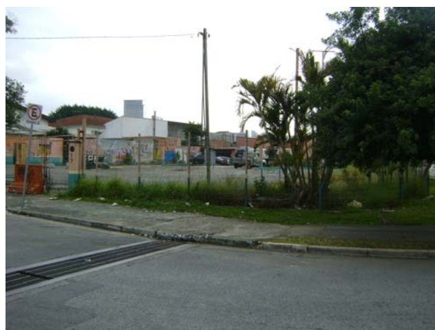
Foto 6.4.9.1-73: Bloco 12A – área de ocupação incipiente. Avenida Jornalista Roberto Marinho com a rua Godói Colaço. Notar a presença de blocos de concreto interditando a área.
