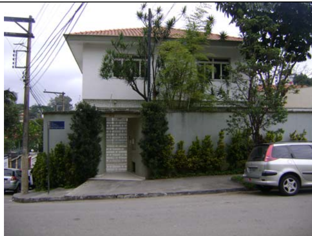
Foto 6.4.9.1-83: Bloco 13B – Residencial horizontal de padrão médio, com estado bom de conservação, rua Barão de Sabará.
