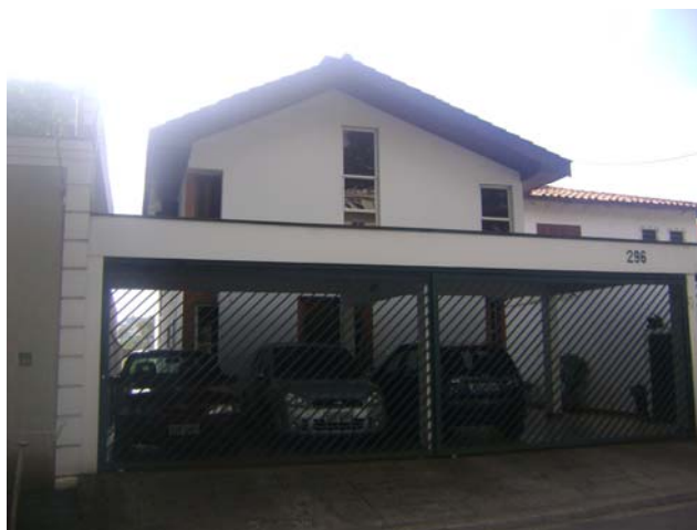
Foto 6.4.9.1-10: Bloco 02A – Residencial horizontal de padrão alto, bom estado de conservação. Rua Prof. Alfredo Ashcar.
