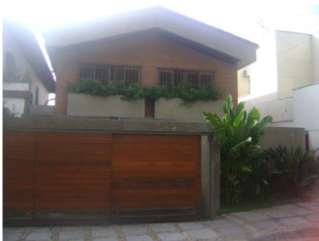
Foto 6.4.9.1-9: Bloco 02A – Residencial horizontal de padrão alto, bom estado de conservação. Rua Prof. Alfredo Ashcar.
