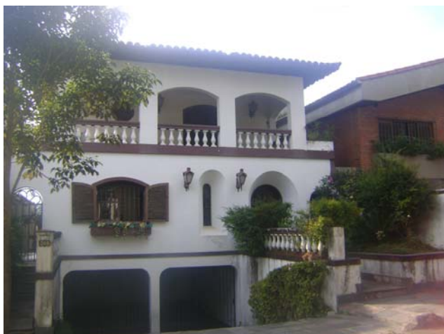
Foto 6.4.9.1-7: Bloco 02A – Residencial horizontal de padrão alto, bom estado de conservação. Rua Prof. Alfredo Ashcar.
