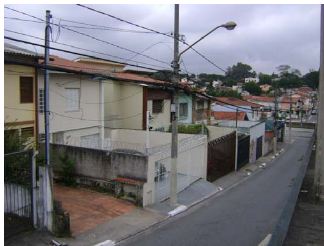
Foto 6.4.9.1-85: Bloco 13B – Vista geral - residencial horizontal de padrão médio, com estado bom e médio de conservação.
