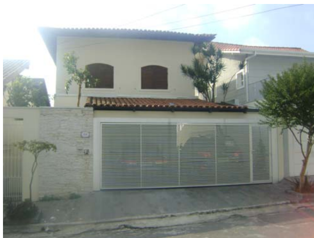
Foto 6.4.9.1-8: Bloco 02A – Residencial horizontal de padrão alto, bom estado de conservação. Rua Prof. Alfredo Ashcar.
