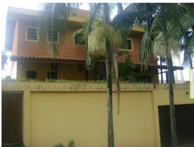
Foto 6.4.9.1-5: Bloco 02A – Residencial horizontal de padrão alto, bom estado de conservação. Rua Prof. Alfredo Ashcar.
