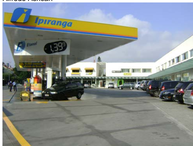
Foto 6.4.9.1-18: Bloco 02A – Comercial e serviço de padrão médio. Área norte do bloco 02A entre a rua Jeriguara e avenida Jorge João Saad.
