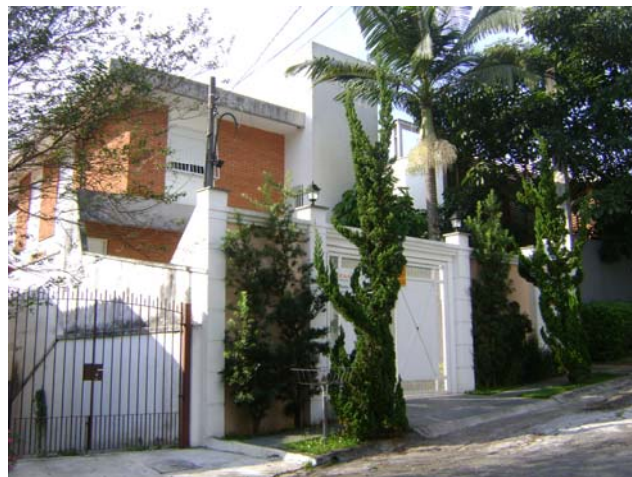
Foto 6.4.9.1-16: Bloco 02A – Residencial horizontal de padrão alto, bom estado de conservação. Rua Prof. Alfredo Ashcar.
