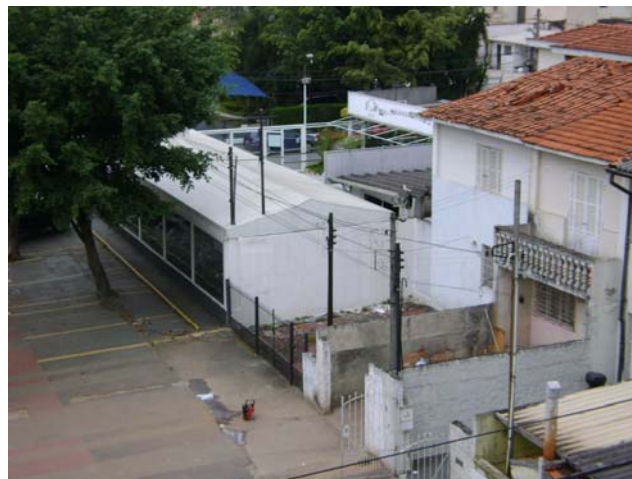
Foto 6.4.9.1-79: Bloco 13A – Comércio e serviço de padrão médio. Ao fundo, revendedora de automóveis e abaixo residencial horizontal de padrão médio com estado ruim de conservação. Avenida Jornalista Roberto Marinho.
