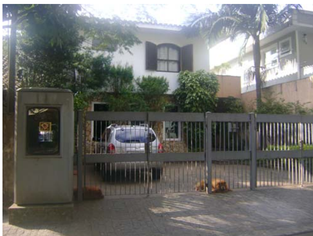
Foto 6.4.9.1-13: Bloco 02A – Residencial horizontal de padrão alto, bom estado de conservação. Rua Prof. Alfredo Ashcar.
