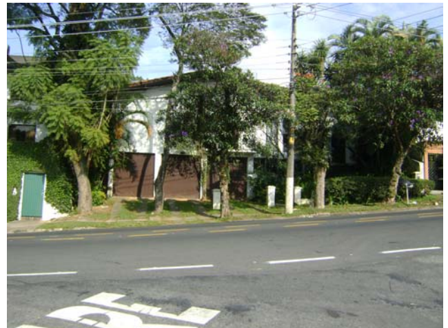
Foto 6.4.9.1-32: Bloco 02A – Residencial horizontal de padrão alto, bom estado de conservação. Rua Corgie Assad Abdalla.
