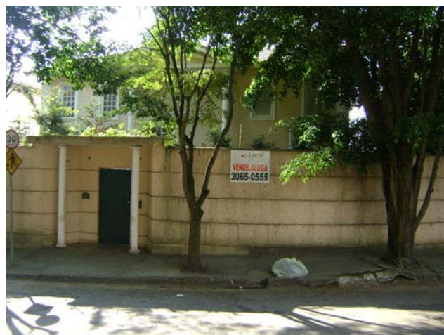
Foto 6.4.9.1-14: Bloco 02A – Residencial horizontal de padrão alto, bom estado de conservação. Rua Prof. Alfredo Ashcar. Detalhe da placa de “vende aluga”.
