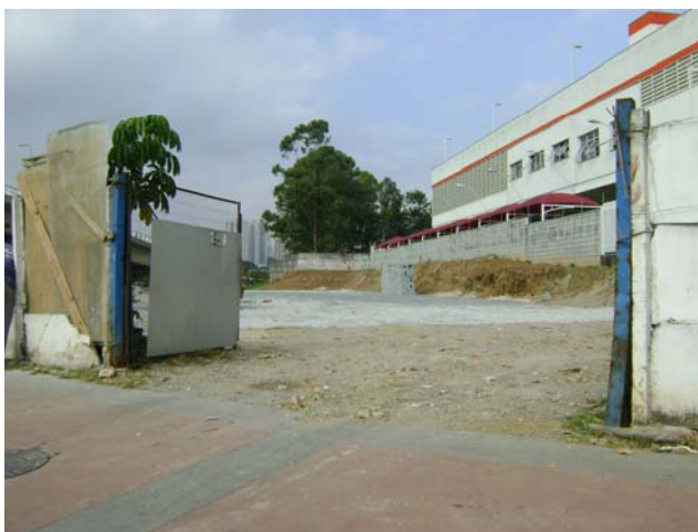
Foto 6.4.9.1-66: Bloco 11 – Área desocupada. Avenida Chucrí Zaidan com a avenida Jornalista Roberto Marinho.
