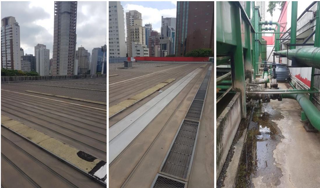
Figura 4. Área de estudo, espaço do telhado do Hipermercado Extra, onde não foram encontrados vestígios de fauna sinantrópica durante o período de vistoria. Atentar para a presença de poças d'água que, se perenes, podem servir de criadouros a mosquitos.
