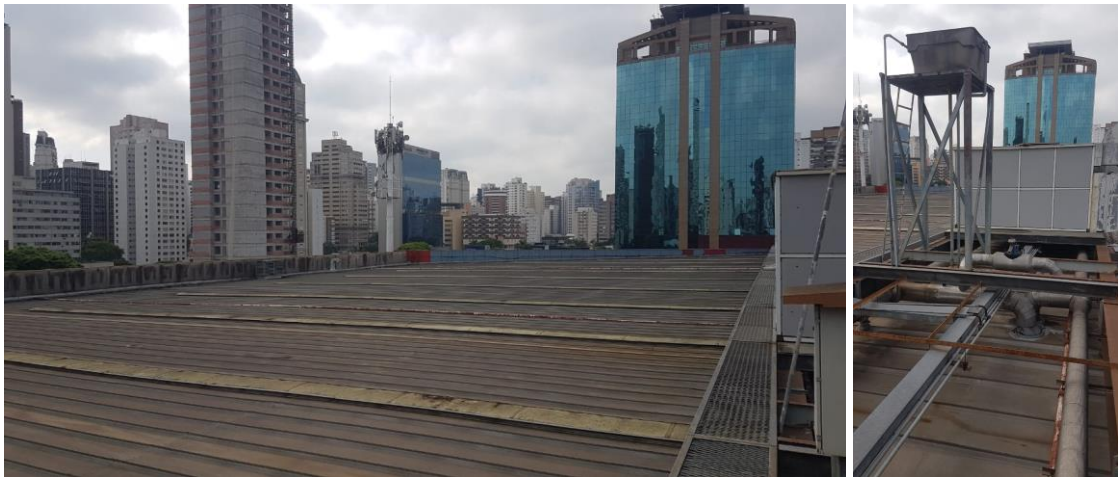
Figura 5. Outra vista da área do telhado, sem vestígios de sinantrópicos durante o período de vistorias.
