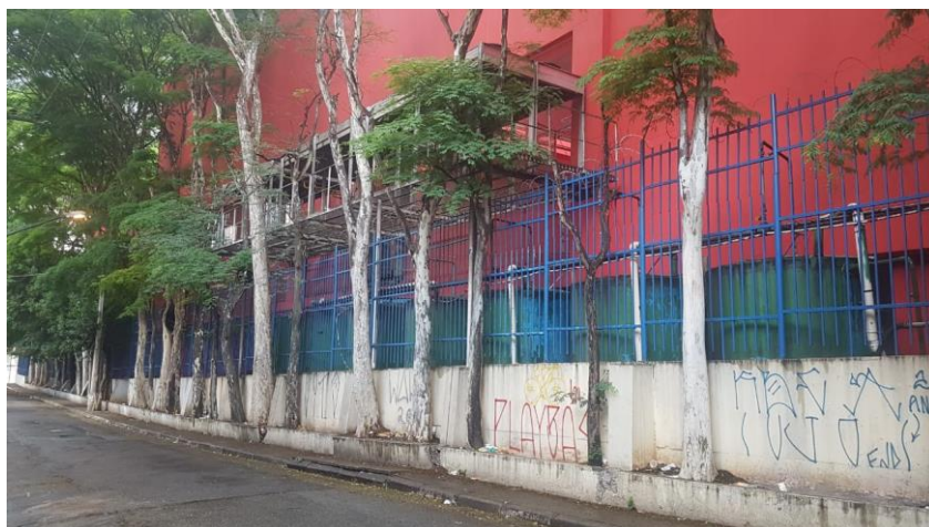
Figura 11. Presença de muitos resíduos acumulados junto às floreiras externas e internas, conferindo ambiente propício (abrigo + alimento) para a fauna sinantrópica.
