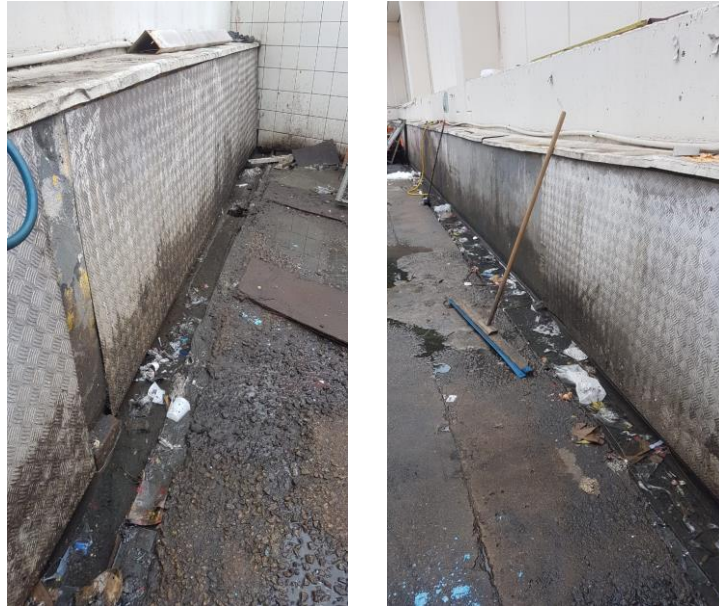
Figura 10. Outra vista da mesma área destinada à separação de resíduos sendo necessário especial atenção quanto a limpeza das canaletas para a remoção dos resíduos sólidos e líquidos, orgânicos e inorgânicos.
