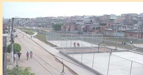
Vila Natal: Obras concluídas na primeira fase do Programa Mananciais
