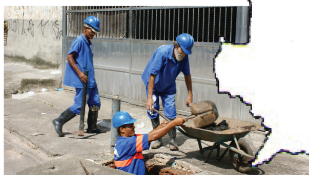
Limpeza de Bueiro
