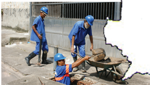
Limpeza de Bueiro
