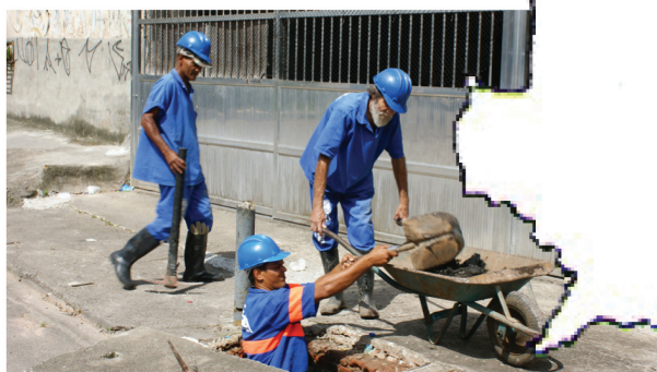
Limpeza de Bueiro
