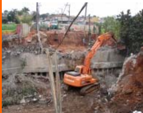
Pontilhão da Rua Dama Entre Verdes Segue com Obras Aceleradas
