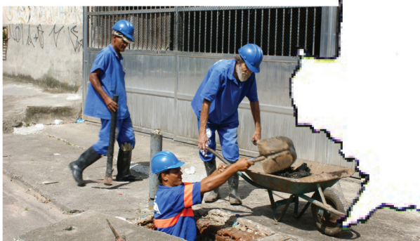
Limpeza de Bueiro
