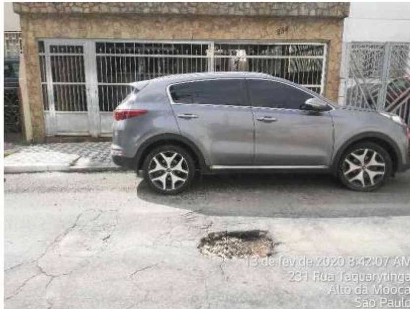
(Foto antes do serviço ser executado, Rua Taquarytinga, 234)
