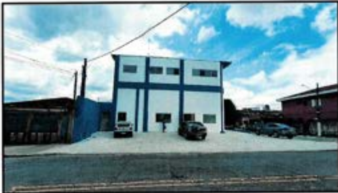
FOTO 1 – Fachada da unidade
