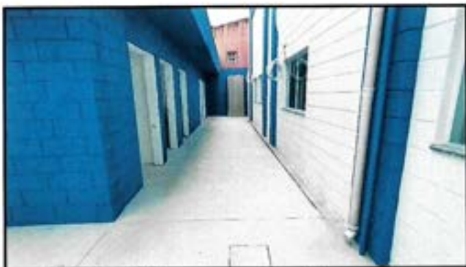
FOTO 9 – Vista acesso aos abrigos
