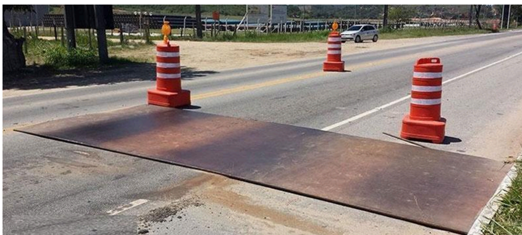
Figura 7: Chapa de aço para tráfego pesado - “chapa tapa vala”
