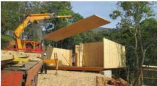
Transporte e montagem dos painéis em CLT
