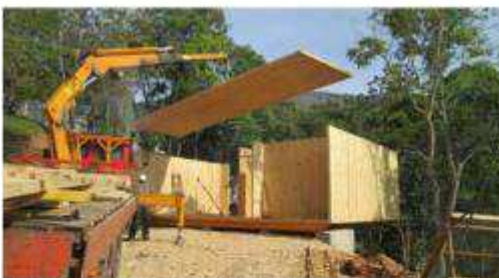
Transporte e montagem dos painéis em CLT
