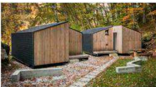
Edifício em CLT. Fonte: Mini for-4 | Archello (Foto: Jazey Maral)
