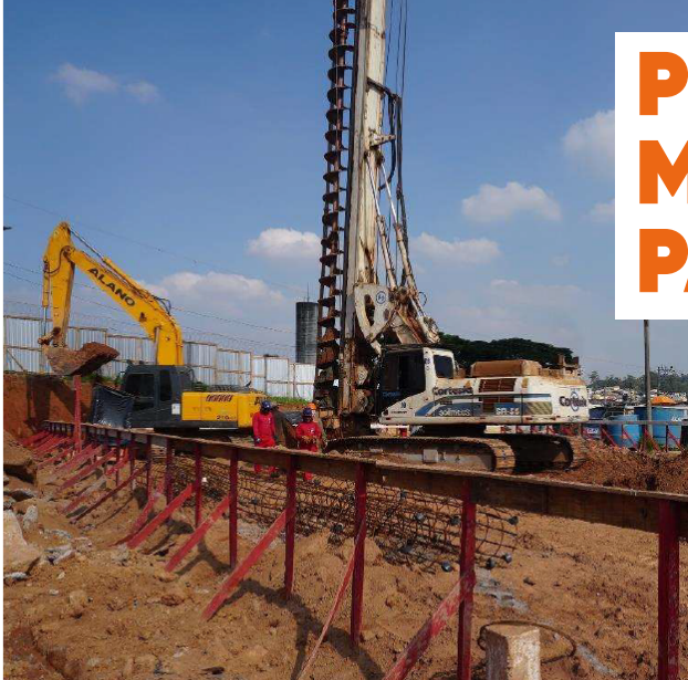
Obras do residencial Perus II
