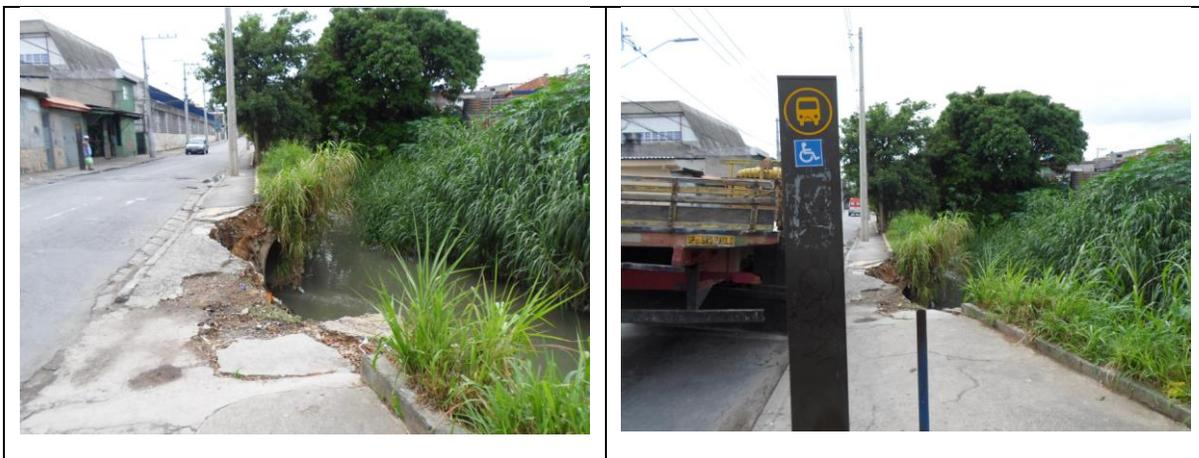
Imagens 09 e 10: Trecho do córrego Itaquera Mirim, situado na Rua Leonilda Magrini, com risco iminente de desmoronamento.
