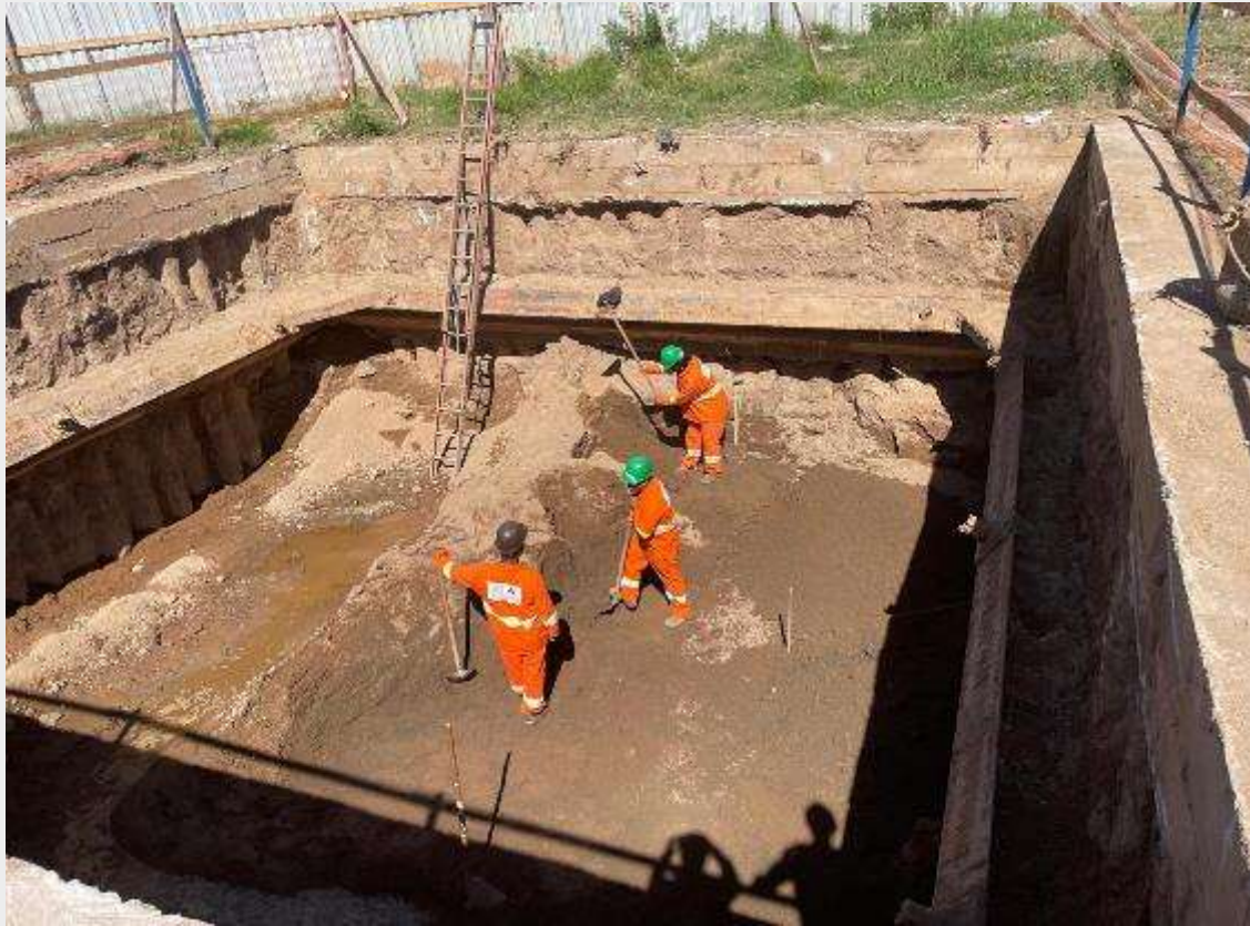
Escavação bloco de fundação – Apoio 2, Ponte (Lado Pirituba)
