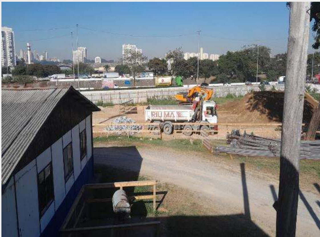
Escavação bloco de fundação – Recebimento de Material – Apoio 2, Ponte (Lado Pirituba)
