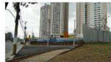
Foto 28 – Vista da rua que tede o plantio e do acesso aos empreendimentos, o muro que atualmente separa o ponto de obra. Foto 07/102016.
