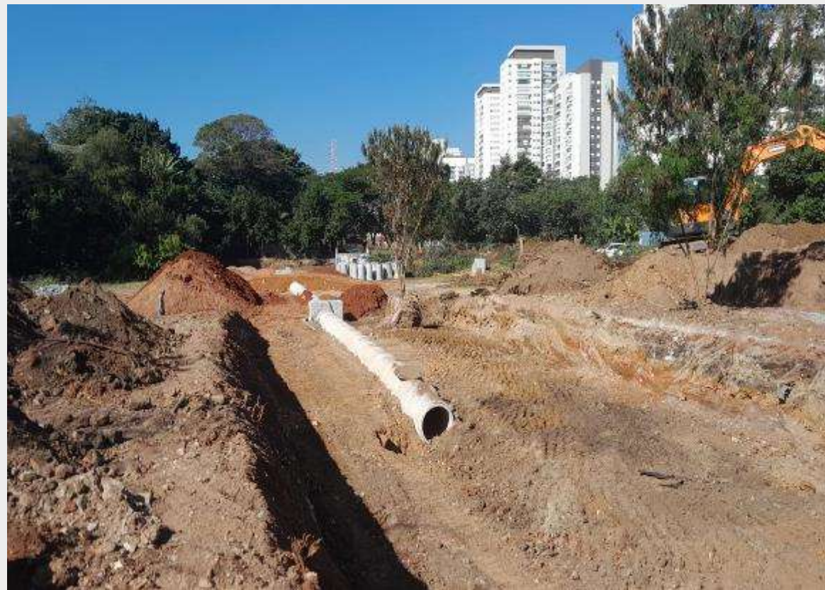
Drenagem, terraplanagem e supressão vegetal – Alça Sul, Lado Lapa
