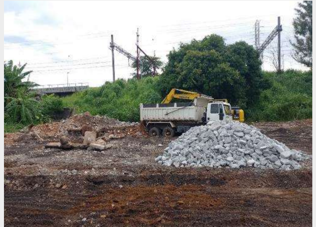
Limpeza e terraplanagem – Alça Sul, Lado Lapa
