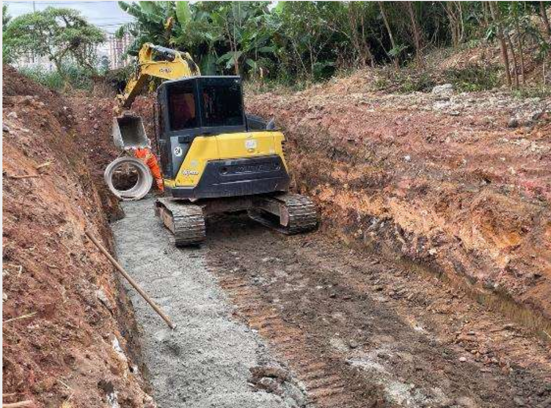
Início execução de Rede de Drenagem – Alça Sul, Lado Lapa
