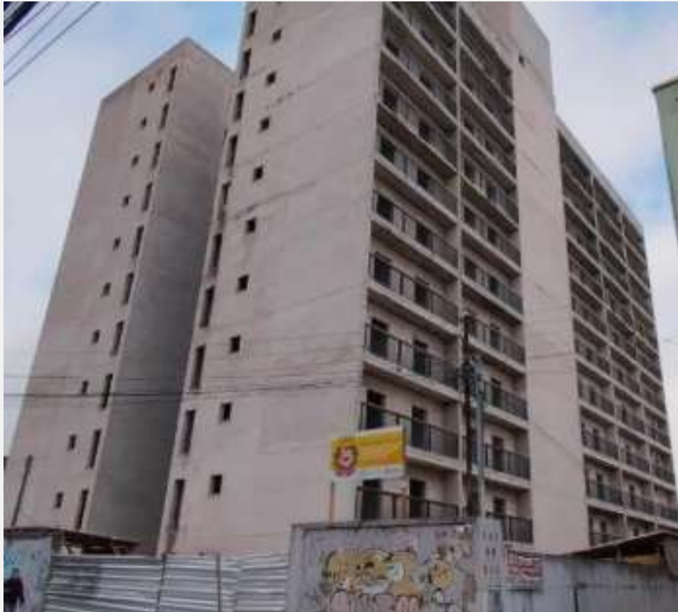
HIS 41 – Vista da fachada: Acabamentos em alvenaria.
