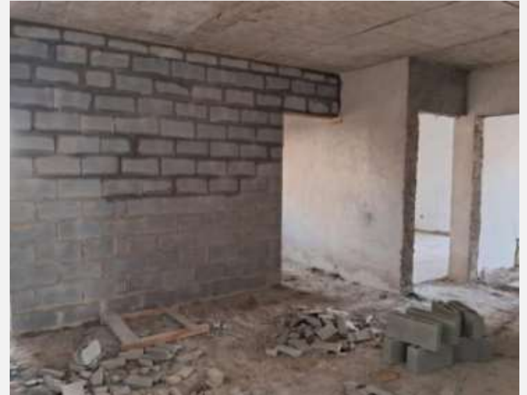
HIS 41 – Execução de alvenaria de divisa no 10º pavimento.
