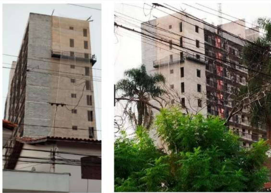
HIS 27 – Vistas da fachada: Acabamentos em alvenaria (chapisco e emboço).
