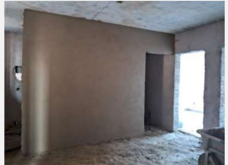
HIS 41 – Finalização de chapisco e emboço no 1º pavimento.
