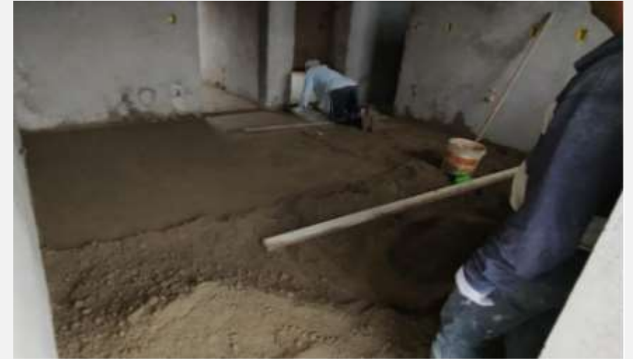
HIS 27 – Execução do contrapiso até o 4º pavimento.
