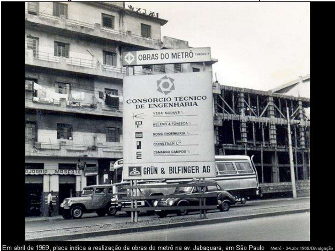
Figura 17: Placa indicativa de obras do metrô na avenida Jabaquara
