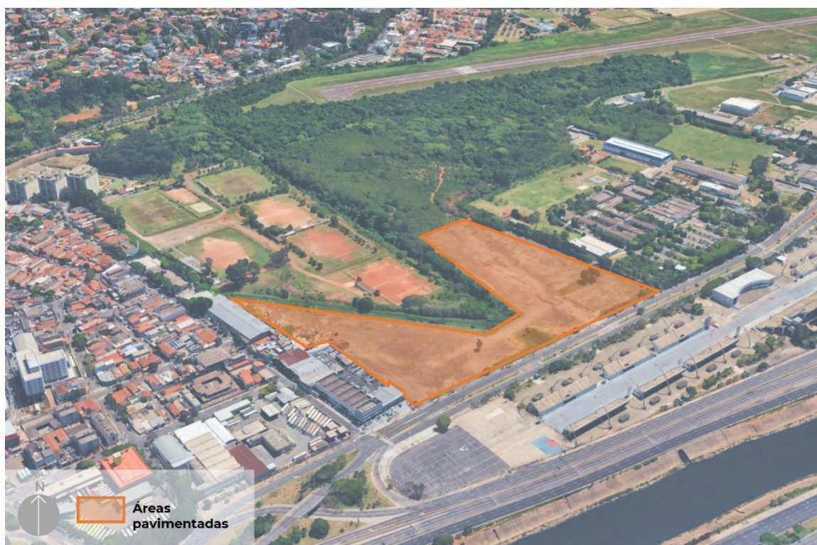
Figura 15 - Áreas pavimentadas na área do Município, frontais à Avenida Olavo Fontoura
