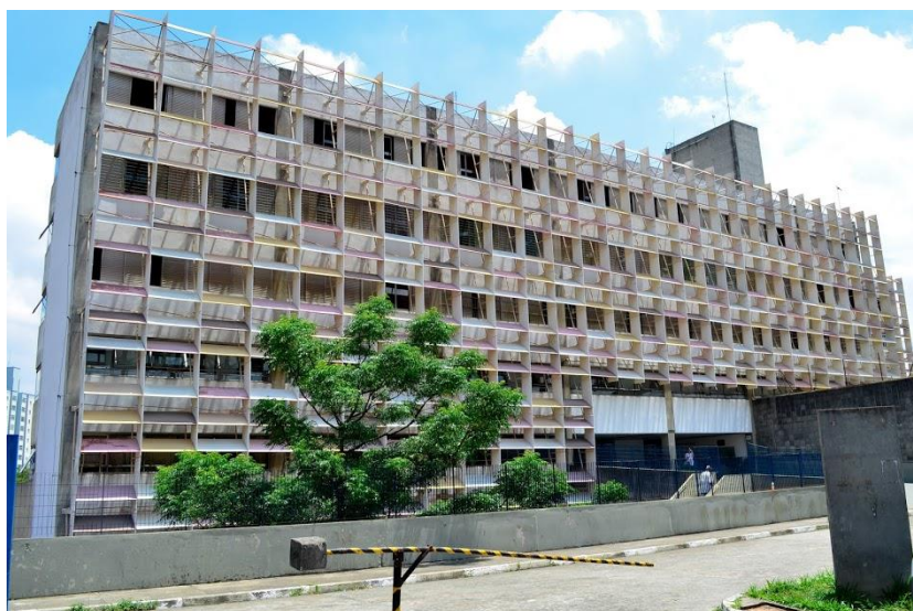
Figura 7 – Fotografia do Hospital Municipal Dr. Alípio Corrêa Netto
