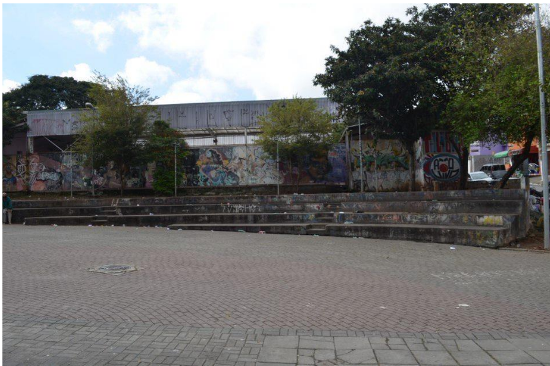
Figura 2 – Calçada do Grajaú
