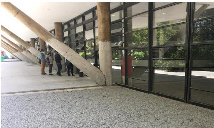
PACUBRA. Detalhe da execução embargada do piso em concreto desempenado, sendo feito sobre o piso existente, com prejuízo à volumetria dos pilares e drenagem dos caixilhos. Foto: Diana Danon, set/2021.
