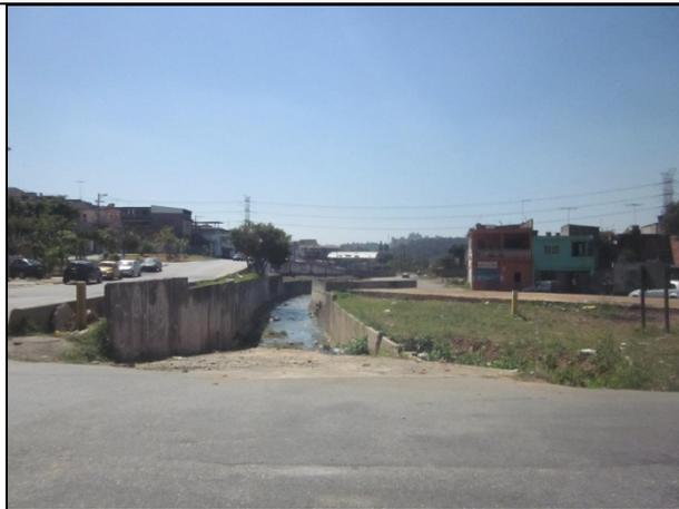
**Foto 11:** Córrego dos Machados à montante do Reservatório Machados – retificado e canalizado
