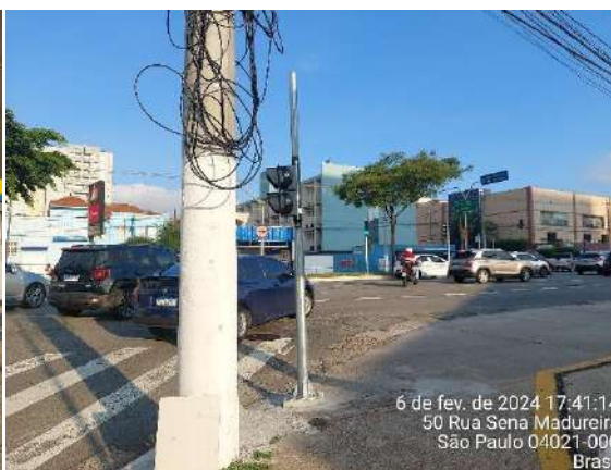
Foto 24 - Vista da esquina da Avenida Sena Madureira com a Rua Domingos de Moraes.
