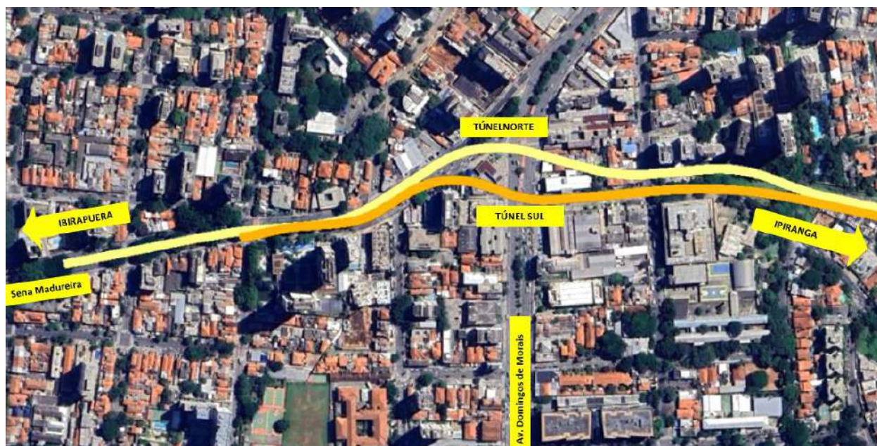
Figura 02 – Túneis do Complexo Viário Sena Madureira.
