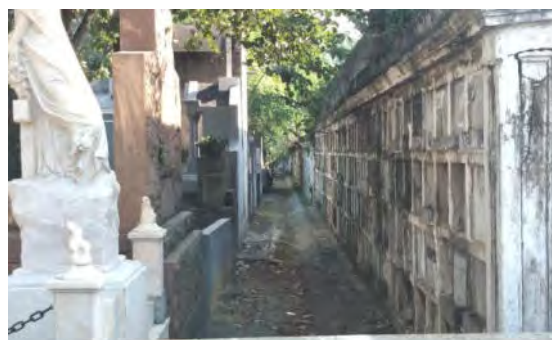
Foto 9.1.7.5-6 - Sarjeta na R35, faixa superior do Cemitério
