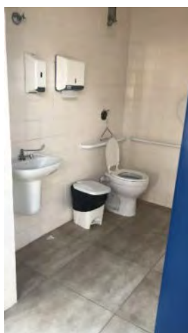
Foto 9.3.2-3 – Vista do lavatório com as barras de apoio e área de transferência
