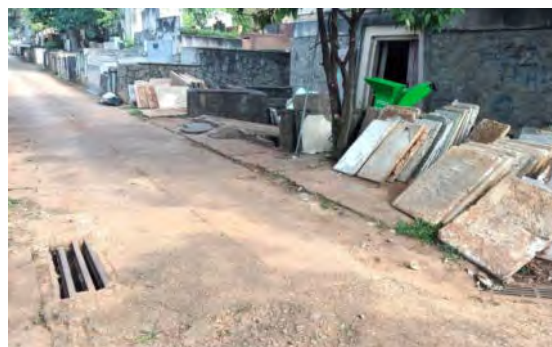
Foto 9.1.7.5-10 - Bueiros interligados às galerias subterrâneas de águas pluviais, atrás do Ossuário Geral.
