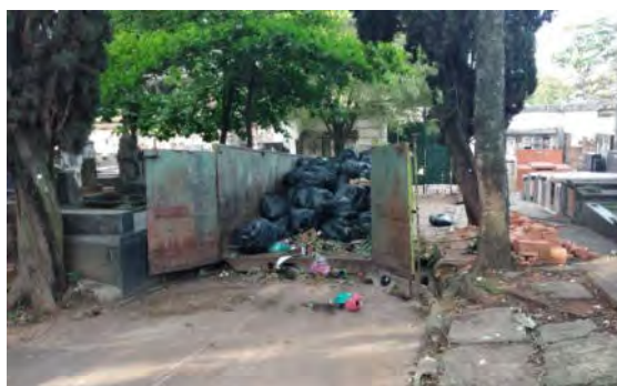
Foto 9.1.7.4-1 – Local de armazenamento de resíduos sólidos, próximo ao portão da R34.
