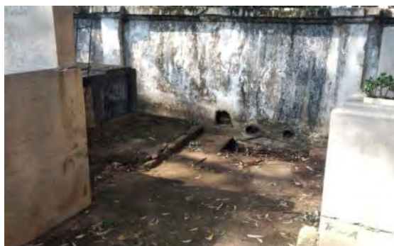
Foto 9.1.7.5-9 – Saídas d'água no muro para a rua Monsenhor Alberto Pequeno
