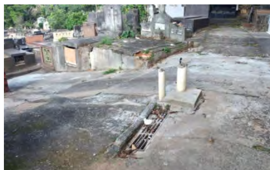
Foto 9.1.7.5-8 - Bueiros ao lado de torneiras de fornecimento de água.
