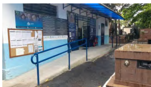
Foto 9.3.2-2 – Rampa de acesso ao administrativo
