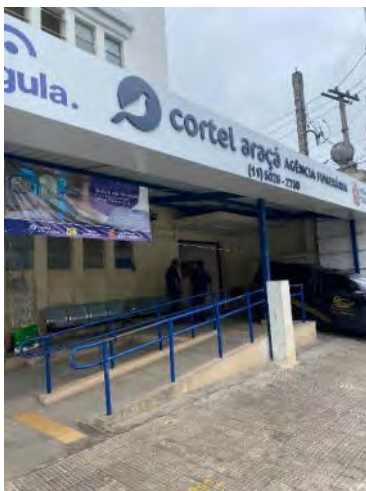
Foto 9.3.2-7 – Rampa de acesso à agência funerária e velório
