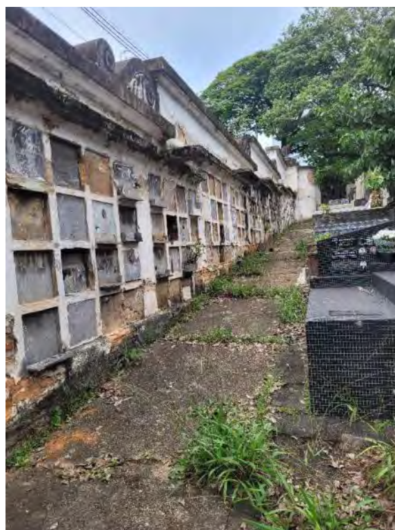
Foto 5.1.3 - Vista geral do ossuário do cemitério
