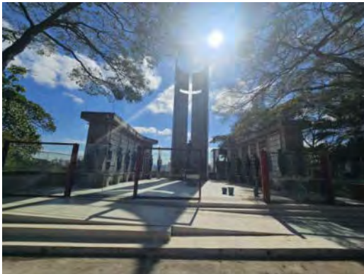
Foto 9.3.2-5 – Vista da rampa de acesso ao Mausoléu da Polícia Militar
