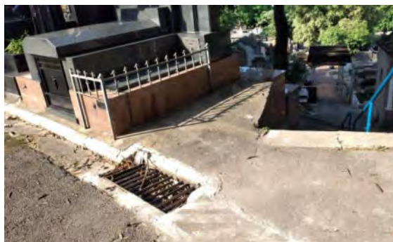
Foto 9.1.7.5-1 - Bueiros próximos à escadaria na Quadra 23.
