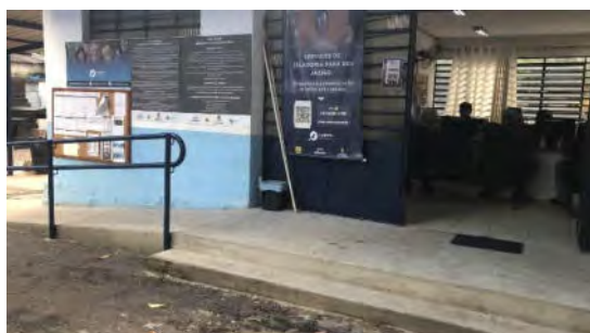
Foto 9.3.2-1 – Acesso à administração
