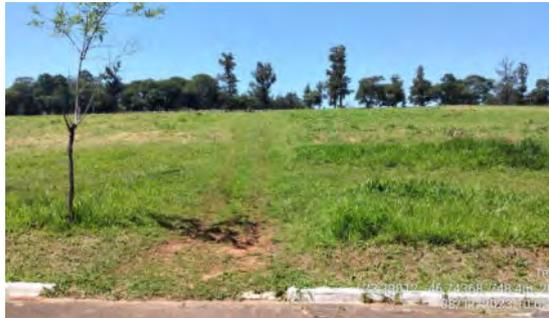
**Foto 9.1.7.5-11** – Erosão próxima a uma das ruas internas
