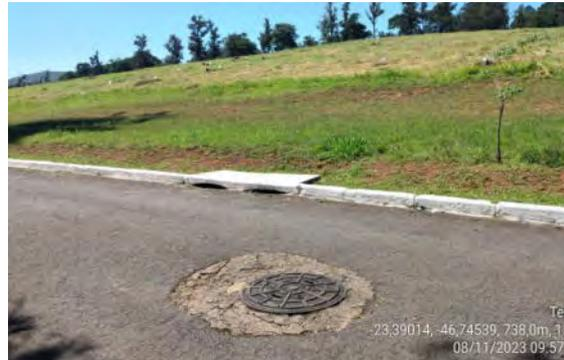
**Foto 9.1.7.5-6** - Bueiros interligados à rede subterrânea de águas pluviais
