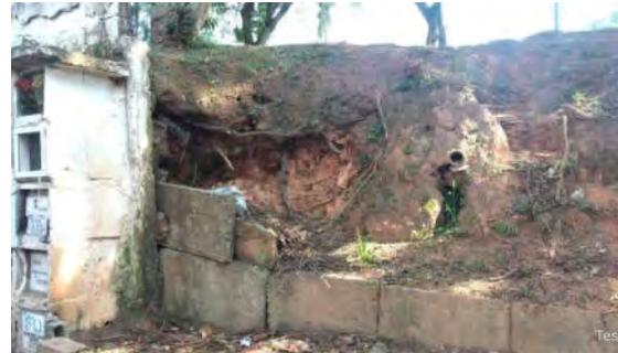
**Foto 9.1.7.5-8:** solapamento atrás de muro do ossário próximo à R08.
