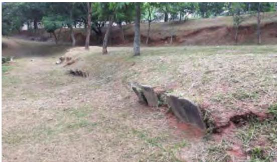
**Foto 9.1.7.5-1** – Contenção de desbarrancamento com placas de concreto, nas imediações da Quadra Geral.
