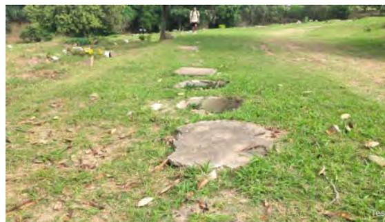
**Foto 9.1.7.5-6** - Estruturas de drenagem sem tampas, próximo à Quadra Geral no setor leste
