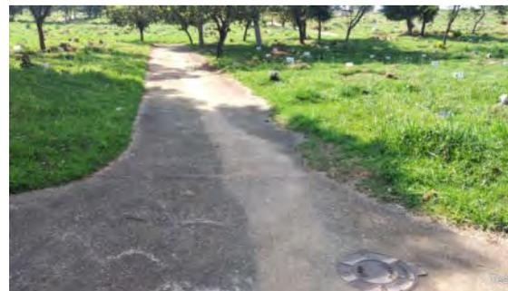
**Foto 9.1.7.5-12:** Arruamento com piso impermeável e buerio de sistema de drenagem impermeável, próximo à Quadra 02.
