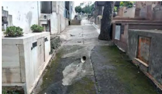
Foto 9.1.7.5-7 - Galeria subterrânea isolada, situada após a entrada do prédio da Administração/Velório.
