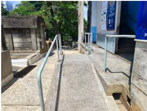
Foto 9.3.2-5 - Rampa de acesso à área de sepultamentos
