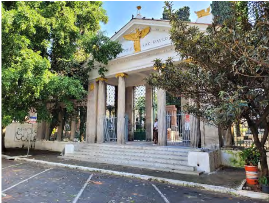
Foto 5.1.1 - Vista da fachada do Cemitério São Paulo
