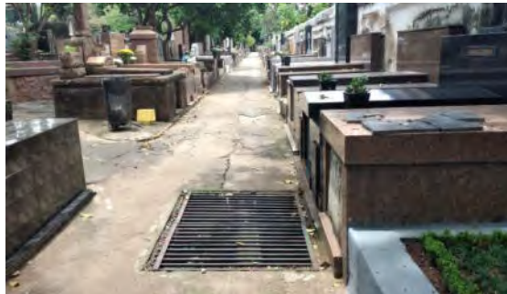
Foto 9.1.7.5-5 - Bueiros na via R1E.
