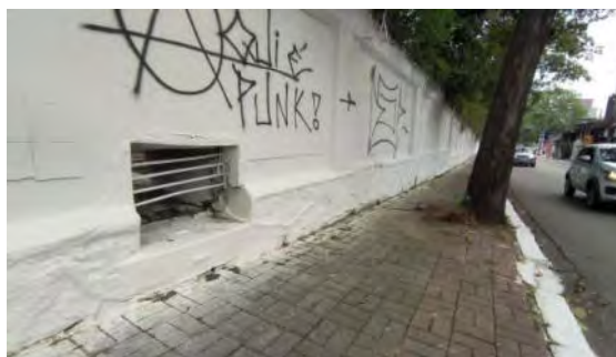
Foto 9.1.7.5-3 - Saída de escoamento de águas pluviais em muro na esquina da rua Luis Murat (o qual abriga parte do ossário).
