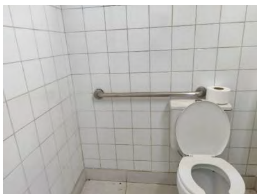
Foto 9.3.2-3 – Barra de apoio no lavatório
