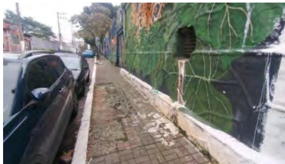
Foto 9.1.7.5-1 - Saída de escoamento de águas pluviais no muro da rua Horacio Lane x Rua Cardeal Arcoverde.
