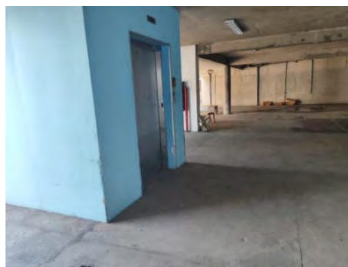
Foto 9.3.2-2 – Elevador de acesso ao prédio administrativo e salas de velório
