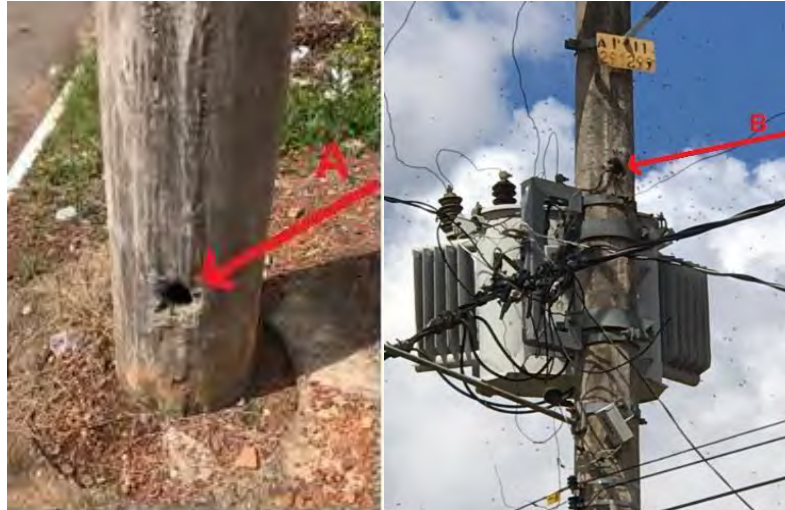
Figuras 6 e 7 - Abelhas nidificadas em postes circulares de concreto de dois orifícios. Realizar controle na sequência de A – B apresentada
