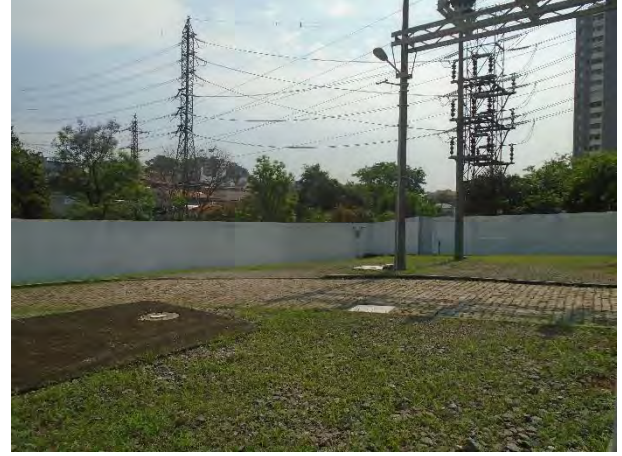
Foto 04: Vista do muro do limite norte da área da ETD Buenos Aires. O traçado da LTS São Miguel – Norte 1-2 deverá seguir ao lado do muro, na parte interna da ETD. Visada em sentido norte.
