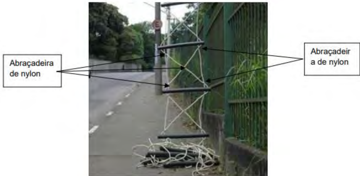
Figura 1 – Passagem de fauna
