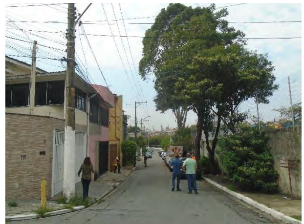
Foto 10: Vista geral da área onde está prevista a implantação de uma caixa de emenda da LTS São Miguel – Leste 1-2, na Rua Joaquim Ornelas. As obras serão concentradas na rua, portanto não há necessidade de corte de árvores nesse ponto. Visada em sentido leste.
