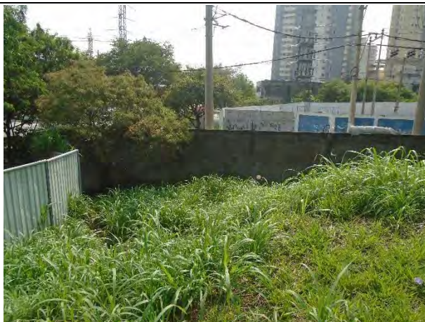
Foto 05: Vista do local onde o traçado da LTS São Miguel – Norte 1-2 sai da Subestação São Miguel em direção à ETD Buenos Aires, atravessando a Rua Maria Leocádia. Visada em sentido leste.
