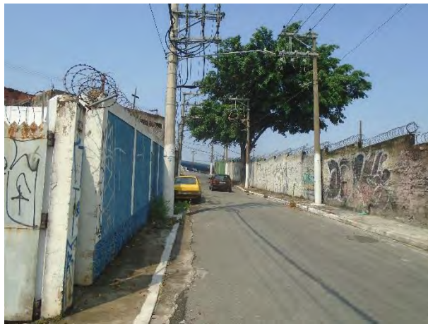
Foto 07: Vista da Rua Maria Leocádia, sentido sul. De onde parte o traçado da LTS São Miguel – Leste 1-2, a partir da SE São Miguel. Visada em sentido sudoeste.
