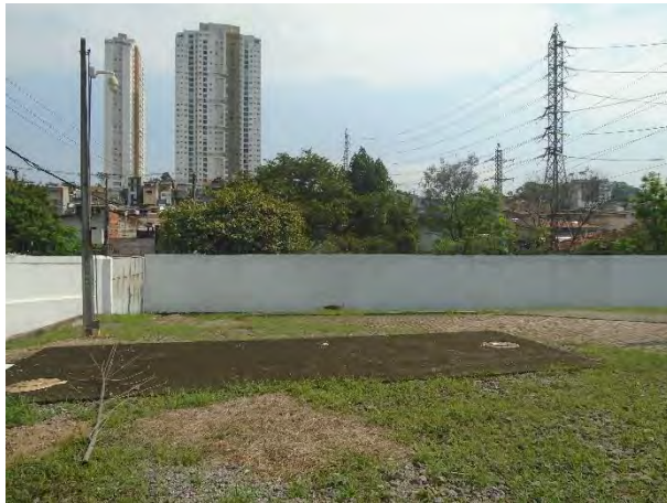
Foto 03: Vista do muro do limite norte da área da ETD Buenos Aires. O traçado da LTS São Miguel – Norte 1-2 deverá seguir ao lado do muro, na parte interna da ETD. Visada em sentido norte.
