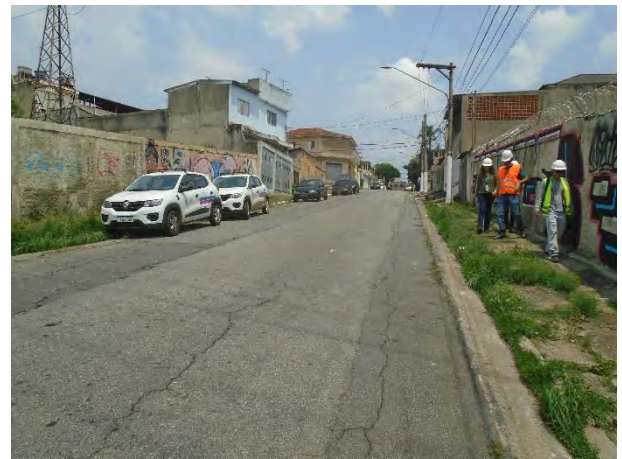
Foto 14: Vista do ponto onde o traçado da LTS São Miguel – Leste 1-2 sai da Rua Domingos de Carlo e entra no terreno da futura ETR Vila Olívia.
