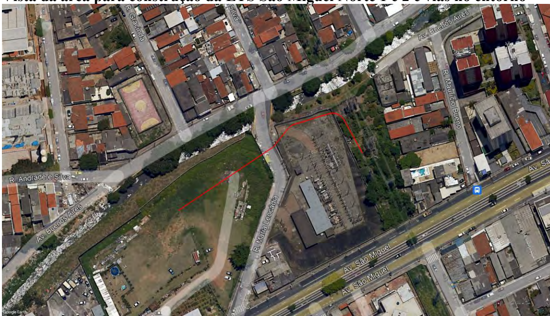
Figura 6.1.a Vista da área para construção da LTS São Miguel Norte 1 e 2 e vias no entorno
