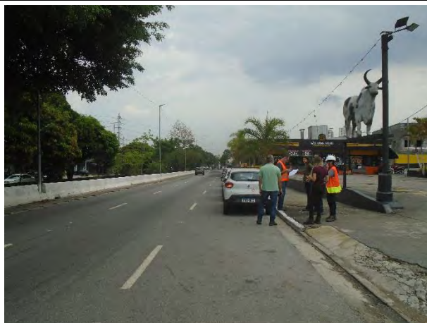
Foto 11: Vista geral da Av. Dom Helder Câmara, sentido noroeste. O traçado da LTS São Miguel – Leste 1-2 percorrerá esse trecho da avenida pelo canto da faixa de rolamento.
