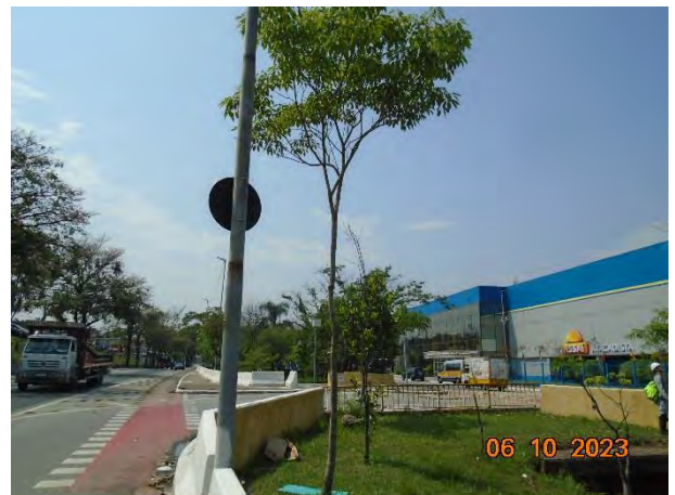
Foto 18: Vista geral do local onde o traçado da LTS São Miguel – Vila Olívia 1-2 atravessa o Córrego Franquinho, entre as pistas da Av. Dom Helder Câmara, entre o Atacado Assai e o Auto Shopping Tiquatira. Visada em sentido sudeste.
