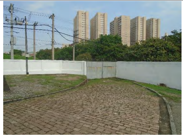
Foto 02: Vista do muro do limite norte da área da ETD Buenos Aires. O traçado da LTS São Miguel – Norte 1-2 deverá seguir ao lado do muro, na parte interna da ETD. Visada em sentido oeste.
