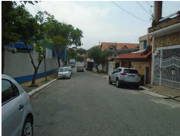
Foto 19: Vista da Rua Dona Joaquina Santana, onde estão previstas obras na faixa de rolamento, para construção da LTS São Miguel – Vila Olívia 1-2. Visada em sentido nordeste.
