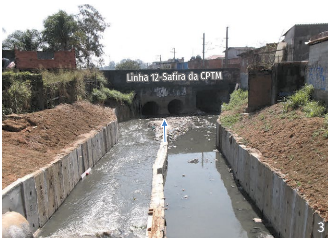
FIGURA 2.26 Trecho médio do ribeirão Lajeado, com obra emergencial de canalização entre a R. Mte. Camberela e a Av. Mal. Tito, em outubro de 2023
