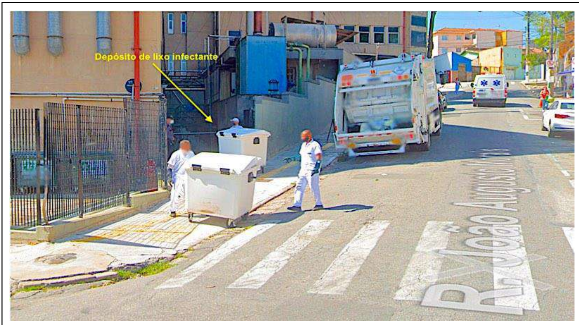
Figura Nº 33: Hospital Tide Setúbal. Depósito de resíduo infectante com acesso pela rua João Augusto Moraes. O depósito é inadequado no que se refere à localização e ao acesso, tipo de piso e sistema de drenagem. Fonte: Google Maps.
