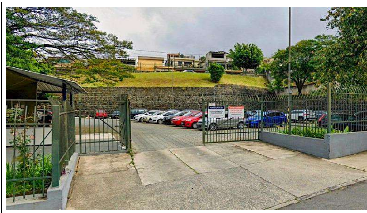
Figura Nº 62: As instalações do hospital Dr. Alexandre Zaio estão deprimidas em relação às ruas no entorno, como mostra essa área de estacionamento. A estabilidade da vertente abrupta da colina está garantida pelo arrimo de gabões, que se mostra acima dos automóveis. Essa área, entretanto, é de preservação permanente, decorrente da presença de uma nascente, e não poderá ser edificada. As obras ocorrerão do lado oposto do terreno, conforme mostra a Figura Nº 16, página 21. (StreetView, 11/2022)
