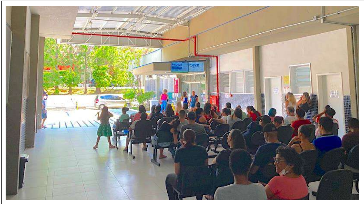
Figura Nº 41: Hospital Municipal e Maternidade Mario Degni. Sala de espera improvisada com a cobertura do vão livre existente entre dois blocos. Local sem conforto térmico (muito quente durante a visita) e sem circulação de ar.
