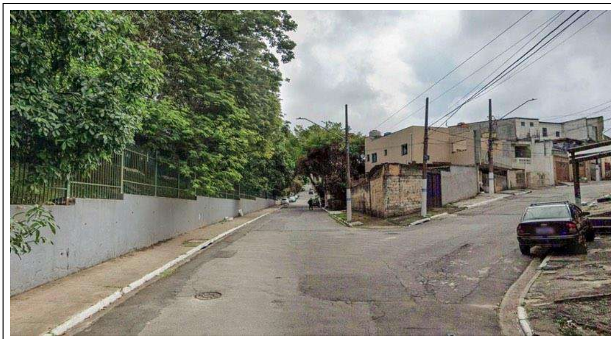
Figura Nº 61: Lateral do Hospital e Maternidade Dr. Alexandre Zaio na rua Alves Maldonado esquina com Eng. Plínio Adans. O hospital foi construído sobre uma área de cabeceira de uma pequena drenagem. Colinas Pequenas com Espigões Locais se apresentarem com declividades um pouco mais acentuadas e com algumas vertentes abruptas, exigindo cuidados adicionais no projeto e implantação das obras de ampliação para garantir a estabilidade do terreno. Fonte: StreetView, 11/2022.
