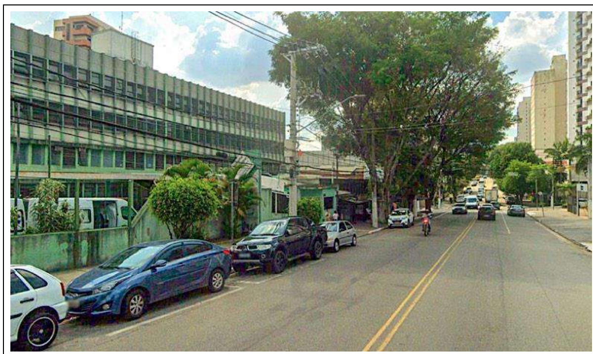
Figura Nº 63: Aspecto bastante suavizado do relevo de Colinas Pequenas mostrado pela rua Juventos na Mooca, local da obra do Hospital Dr. Ignácio Proença de Gouvêa, a esquerda na foto. Os terrenos no entorno do hospital se mostram estáveis, sem problemas de deslizamento de solos e alagamentos. Fonte: StreetView, 03/2023.
