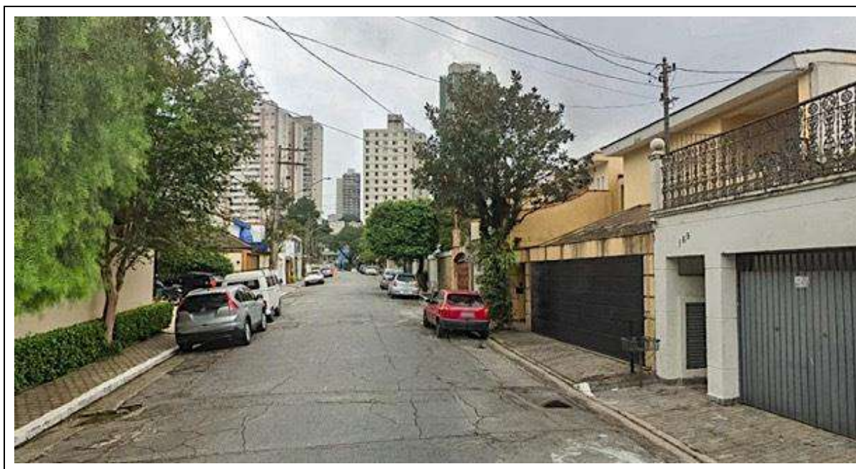
Figura Nº 73: Rua Miguel Zuccas, Mooca. As ruas nas imediações do hospital são mais arborizadas, porém, aquém do ideal. A impermeabilização do solo ainda é alta. Fonte: StreetView, 02/2022.
