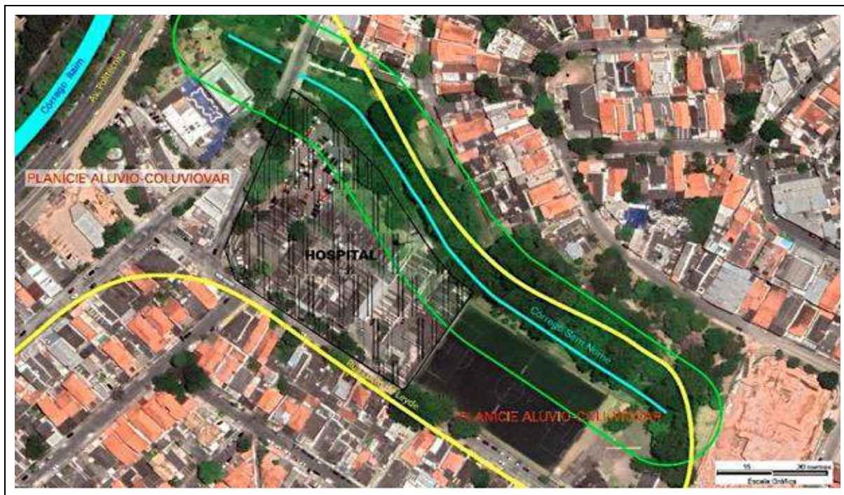
Figura Nº 74: O Hospital e Maternidade Mário Degni é o único localizado junto a um curso d'água, um pequeno córrego que tem sua nascente nas proximidades e que desagua no córrego Itaim, poucos metros a jusante. De acordo com a legislação, a sua área de preservação permanente - APP abrange todos os terrenos localizados até 30 metros de distância de ambas as suas margens. Assim, cerca de 20 metros do terreno do hospital que se estendem paralelamente ao córrego estão sobrepostos à APP, conforme pode ser observado na imagem acima. Destaca-se que todo o trecho do córrego ao lado do hospital está em obras e sua possível condição natural vem sendo muito degradada. Algumas das árvores presentes na imagem não existem mais.
