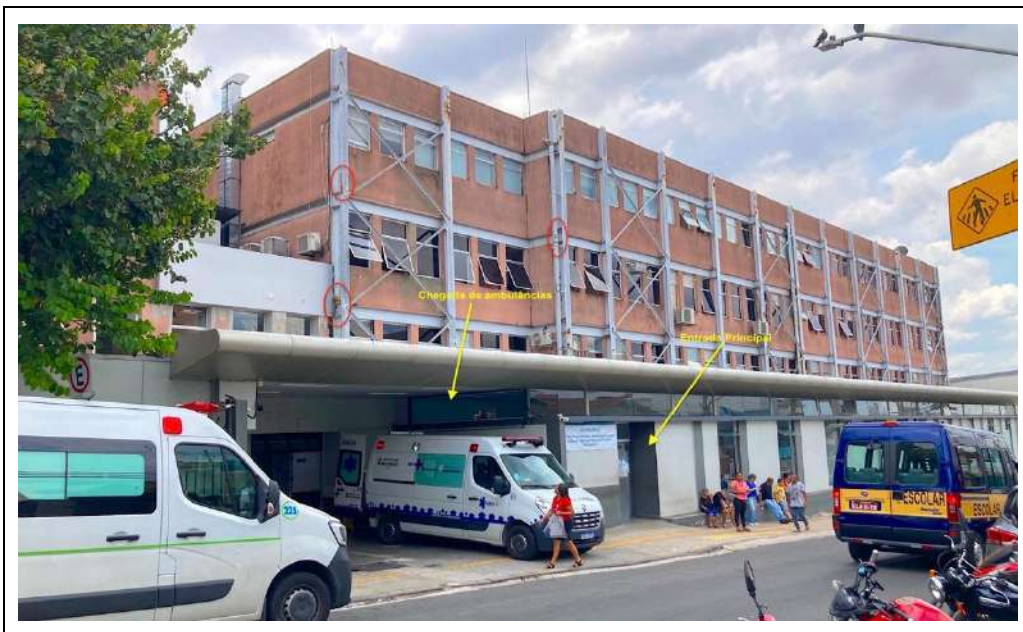
Figura Nº 28: Hospital Tide Setúbal. Locais de chegada de ambulância e entrada de pacientes precários (setas amarelas).
