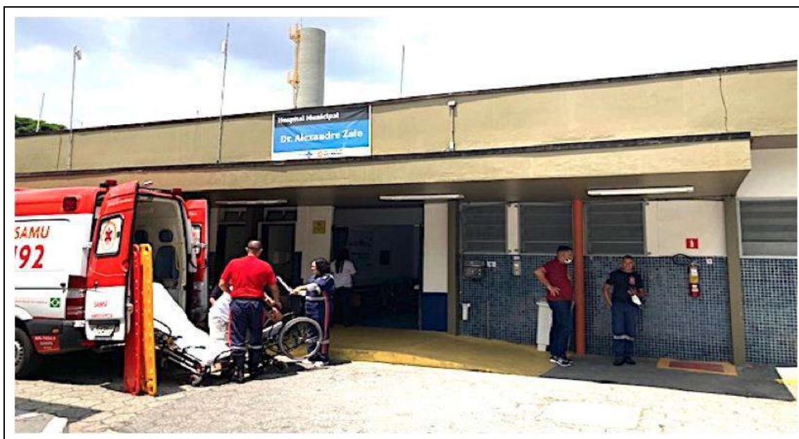
Figura Nº 21: Hospital Municipal Dr. Alexandre Zaio. Área de estacionamento de ambulância para a chegada de pacientes e acesso ao Pronto Socorro. Acesso inadequado, com acessibilidade precária, sem faixa de pedestres e piso tátil e sinalização deficiente.
