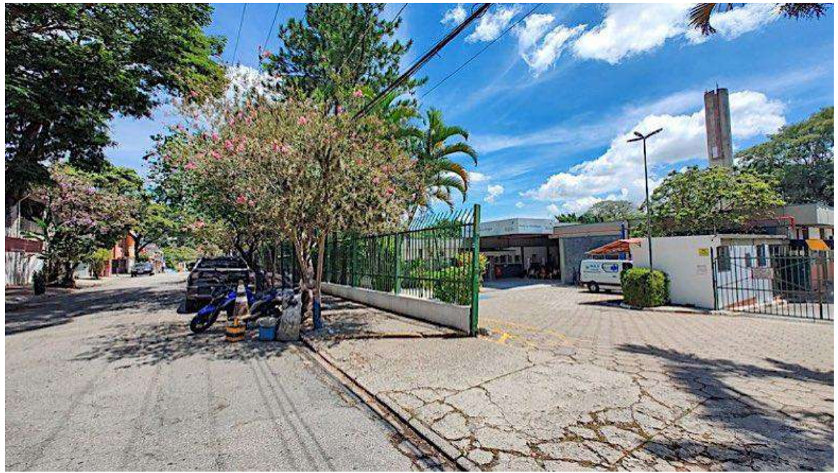
Figura Nº 64: O Hospital e Maternidade Mário Degni está situado no relevo Planícies Aluviais sobre depósitos aluvionares e coluvionares de idade quaternária. Trata-se de uma planície restrita que se estende ao longo das margens do córrego Itaim (afluente do rio Pinheiros) e penetra algumas dezenas de metros pelo córrego Sem Nome. Nota-se a entrada do hospital na rua Lucas de Leyde
