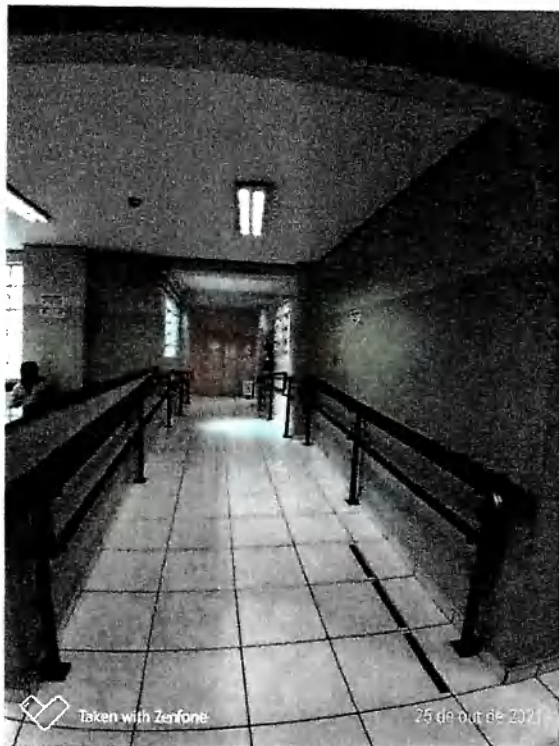
Figura 4-Foto 4 – Vista da rampa interna
